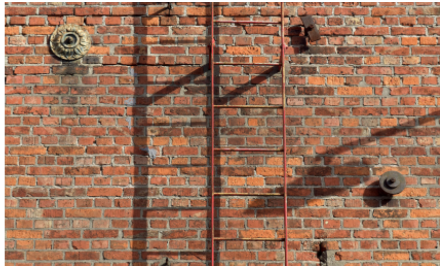
Hergebruik gevelankers ^
