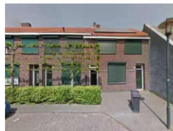
Bestaande situatie Kerkstraat v
