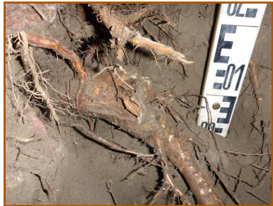
Afbeelding 7: Grote wortel \varnothing 8 cm groeit onder de fundering door
