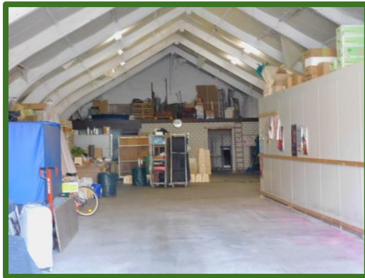
Binnenzijde noordelijke gedeelte van de loods
