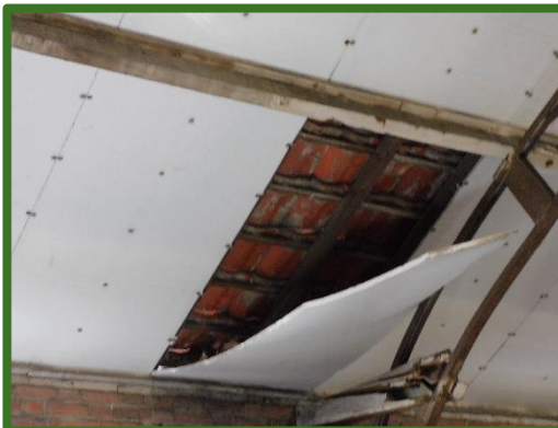
Dakisolatie zuidelijke deel
