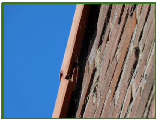
Ruimte onder de dakpannen
