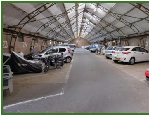
Zuidelijke gedeelte van de loods
