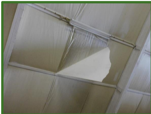
Dakisolatie noordelijke deel
