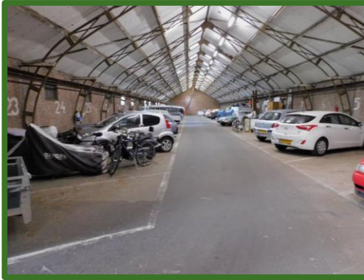
Zuidelijke gedeelte van de loods
