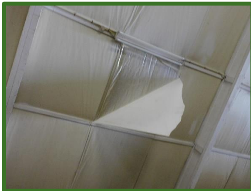
Dakisolatie noordelijke deel
