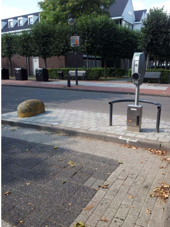
afbeelding 9.1 Laadpunt elektronische voertuigen
