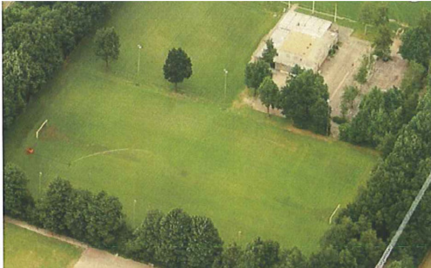
Afbeelding: bestaande situatie velden met bestaande lichtmasten.
