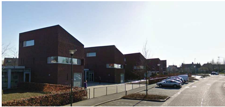
Figuur 4: situatie aan de Hoge Wal, het plangebied (bron: google streetview)
