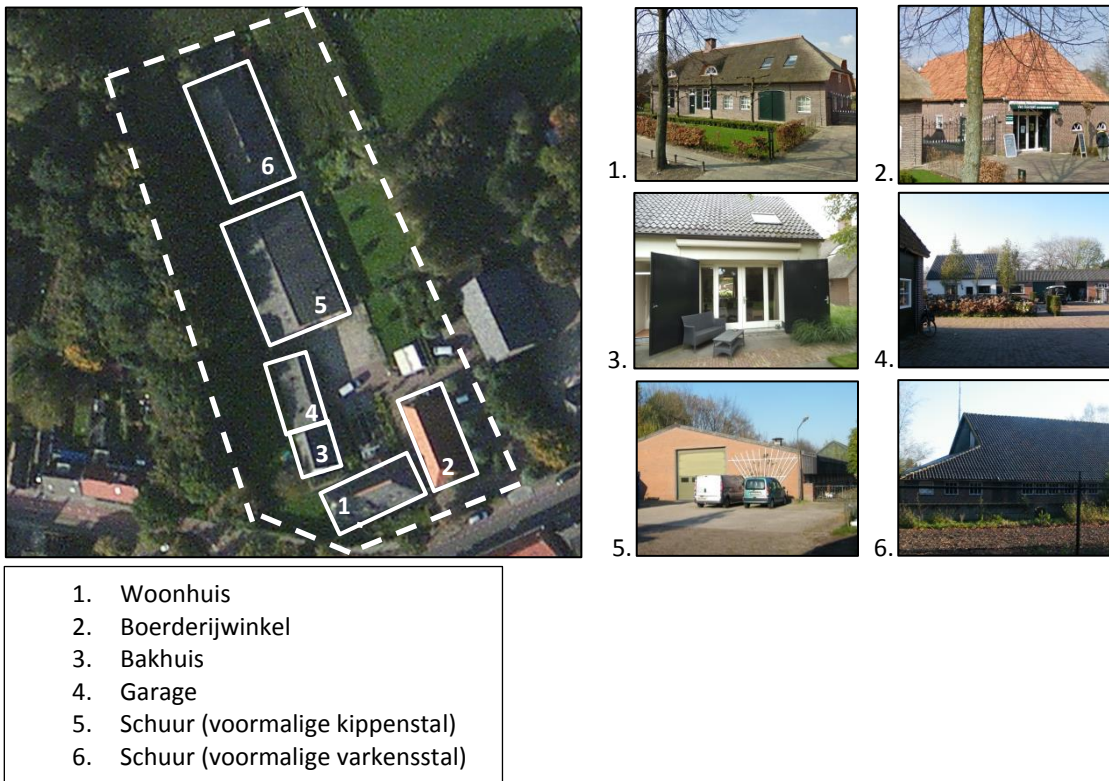
Figuur 1: Luchtfoto plangebied met gebouwen
