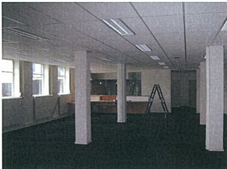
Foto F11: Kantoorroimten begane grond en verdieping, ruimte onder de vaste vloerbedekking: geen destructief onderzoek toegestaan
