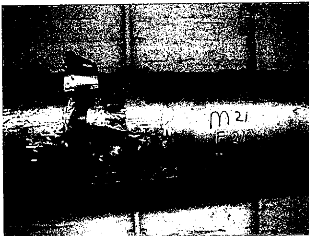
Foto 21: Leidingisolatie om leiding in weverij (buitenste leiding), (begane grond), (M21).
