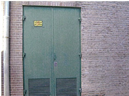
Foto F03: Gebouw 66, hoogspanningsruimte: niet toegankelijk
