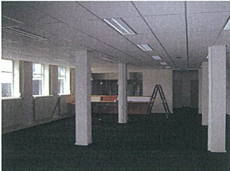
Foto F10: Kantoorroimten begane grond en verdieping, vaste scheidingswanden en vaste wanddelen en ruimten achter de vaste wanden: geen destructief onderzoek toegestaan
