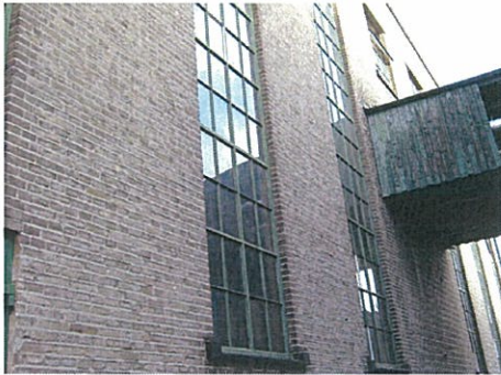
foto: betreft zijgevel ketelhuis
