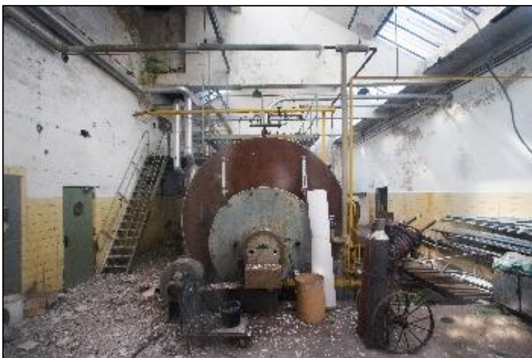
Afbeelding 3.32 Fabrieksschoorsteen, voorgevels van het hoofdgebouw en ketelhuis (op zichzelf niet bijzonder, maar wel het hart van de fabriek vanaf circa 1955) zijn aangewezen als gemeentelijk monument. De aanwijzing wordt bestreden door de huidige eigenaar (foto: A. Oldenmenger).
