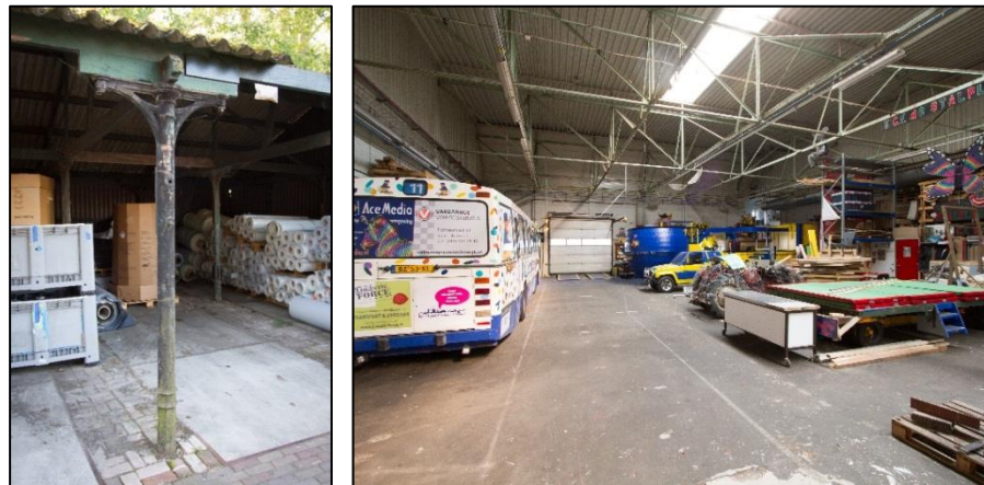
Afbeelding 3.23 Links: De oudste constructieonderdelen zijn te vinden in een stalling aan de Nieuwe Leij, opgetrokken in de jaren vijftig, vermoedelijk met gebruikmaking van kolommen uit een fabrieksgebouw dat moest wijken voor het kantoorgebouw uit 1951-1952. Rechts: Bij enkele hallen zijn de sheddakspanten nog wel aanwezig, onder een nieuw, plat dak (foto's: A. Oldenmenger).
