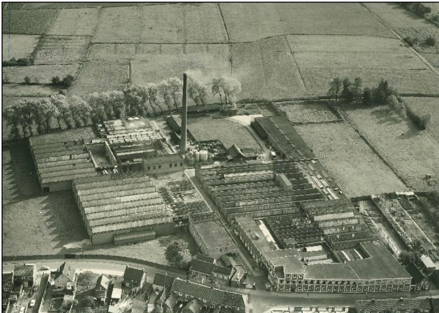
Afbeelding 2.20 Opname vanuit de lucht omstreeks 1960, gemaakt in zuidelijke richting. Op de foto uitbreidingen aan de oostzijde van de fabrieksstraat en aan de Kerkstraat het kantoorgebouw uit 1951-1952. Op het terrein is de huidige fabrieksschoorsteen verrezen. Rondom de fabriek nog vooral weide (Regionaal Archief Tilburg 2014).
