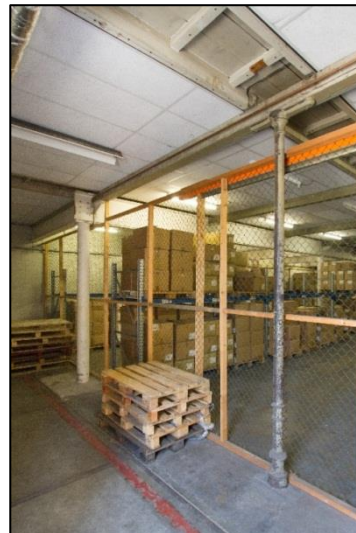
Afbeelding 3.29 Links opname van het voormalige administratiegebouw en de schoorsteen uit omstreeks 1891 (beide rijksmonument). Rechts ranke gietijzeren kolom in één van de laat negentiende-eeuwse productiehallen met sheddaken (foto: A. Oldenmenger).
