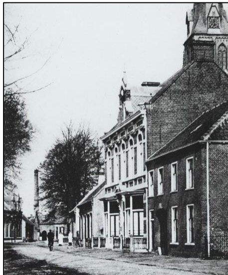
Afbeelding 2.25 Opname uit het begin van de twintigste eeuw met het woonhuis van Van Puijenbroek (tweelaags) en daarachter een café dat korte tijd later zou worden vernieuwd en 'Hotel de Kroon' zou worden genoemd. In de achtergrond de fabrieksschoorsteen van textiel fabriek Van Enschoot (Regionaal Archief Tilburg 2014).
