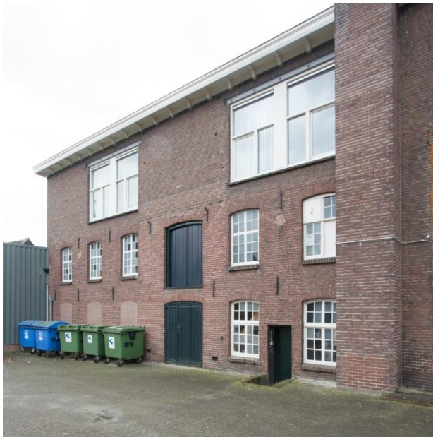
Afbeelding: Voorgevel van het gebouw, op de begane grond en de verdieping laat negentiende-eeuws, met deels de oorspronkelijke invulling van de gevel. De bovenste bouwlaag is een toevoeging. Rechts een aanbestedingsaankondiging voor de bouw van een magazijn. Vrijwel zeker heeft dit betrekking op gebouw VIII. Architect is J.B. Rens.
