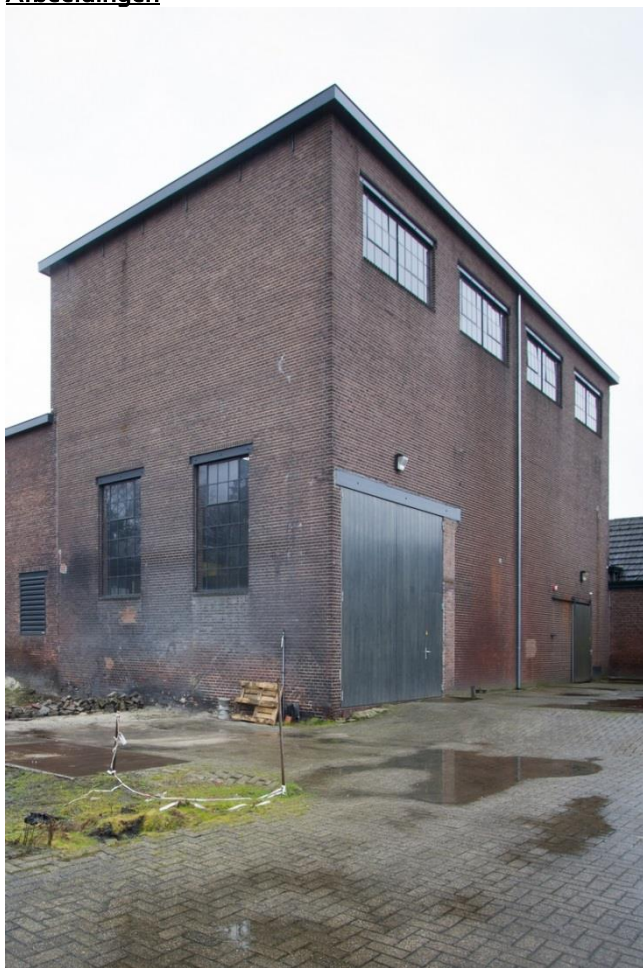
Afbeelding: Het ketelhuis is sinds de bouw in 1934 van buiten weinig veranderd. De grote deur is een toevoeging.
