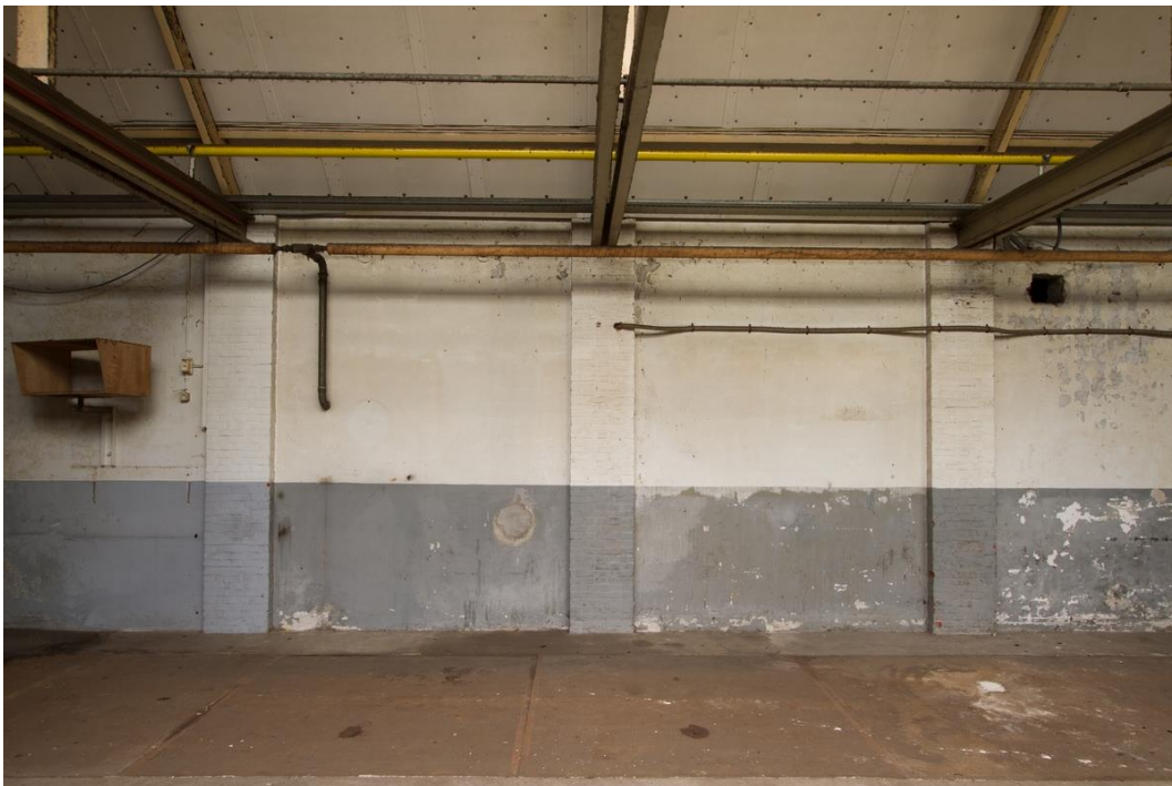
Afbeelding: Het bouwdeel uit 1907 is voorzien van pilasters in de gevels.
