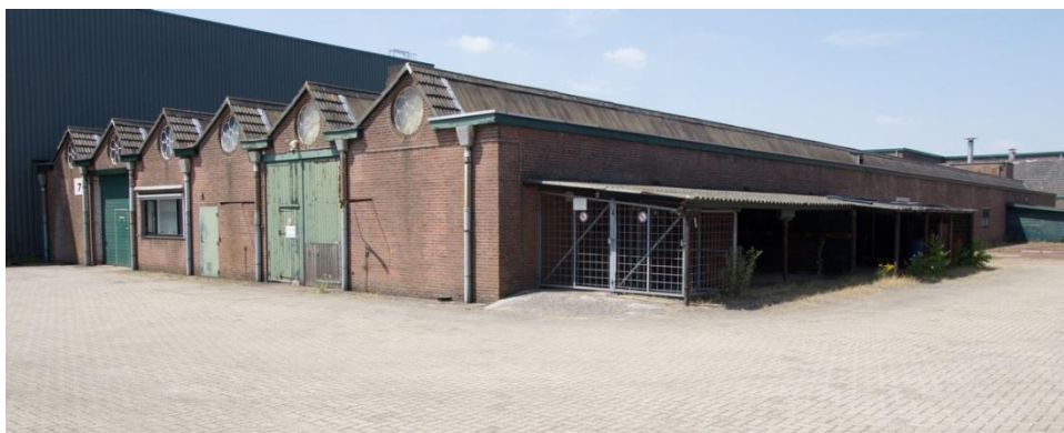
Afbeelding: Fabrieksgebouw uit 1953 met daar tegen aan een toegevoegde berging onder lessenaardak.
