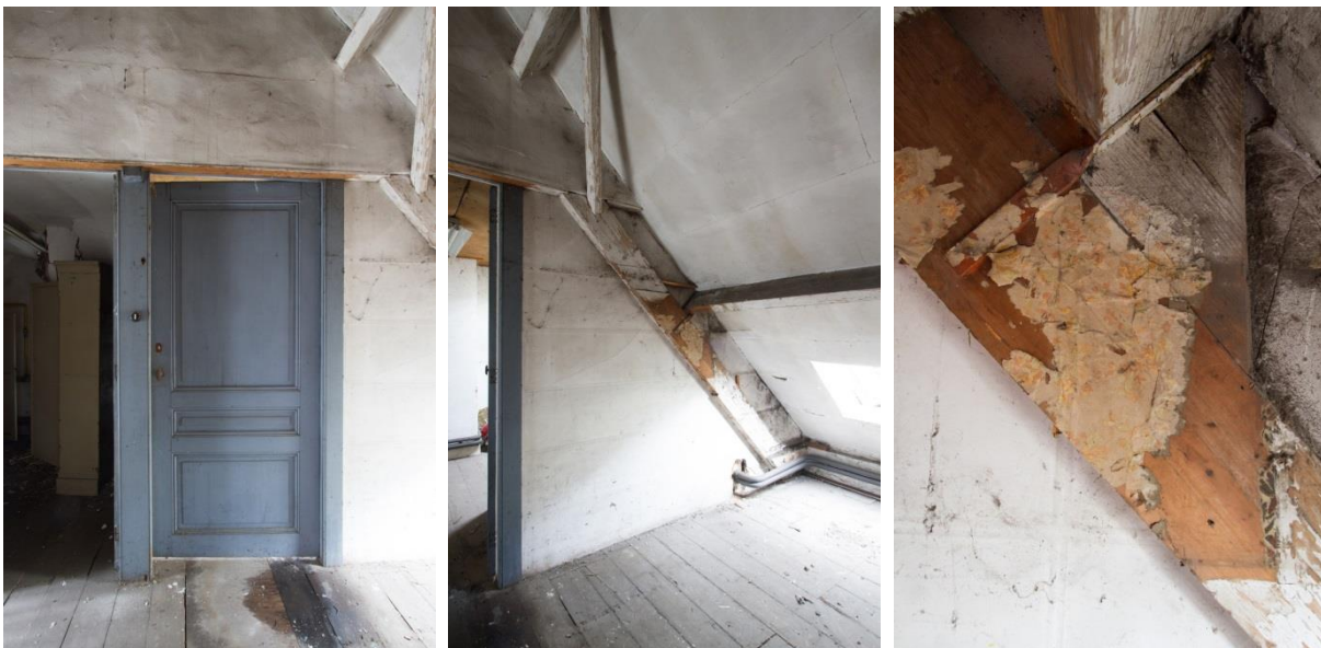
Afbeeldingen: Paneel deur op de zolder (l). Kapsant waarvan de trek balk omhoog is gebracht ten behoeve van de binnendeuren (m). Restanten van behangsel op één van de spantbenen (r).
