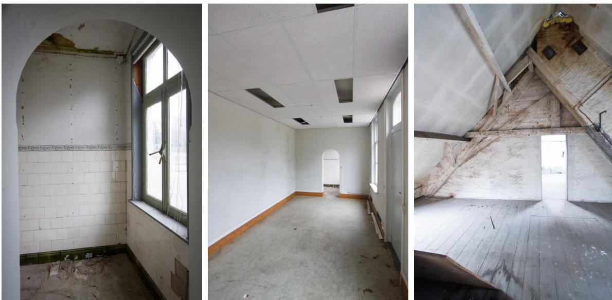
Afbeeldingen: Blik in de voorkamer van de toegevoegde bouwmassa met entree, met een tegellambrisering in lijn met die in de machinekamer uit 1907 (l). Voormalige kantoorruimte achter de voorgevel, ontstaan na sloop van twee gangmuren (m). De zolder van het pand met zicht op een oorspronkelijke rookkanaal en één van de oorspronkelijke spanten.
