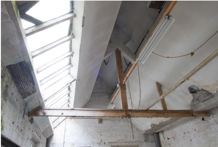
Afbeeldingen: Links een opname van de kapconstructie met rechts de goot óp de balken en een ventilatie- en lichtstraat die later, maar al wel vrij vroeg, zijn toegevoegd. Rechts de inpandig geraakte voorgevel, die oorspronkelijk niet geschilderd was. Deur en vensters zijn uit de bouwtijd.
