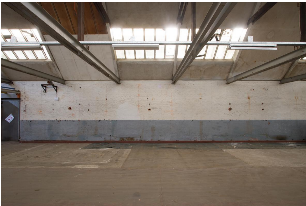
Afbeelding: De voormalige zijgevel van gebouw VI, de weverij. Daarin sporen van dichtgezette gevelopeningen.
