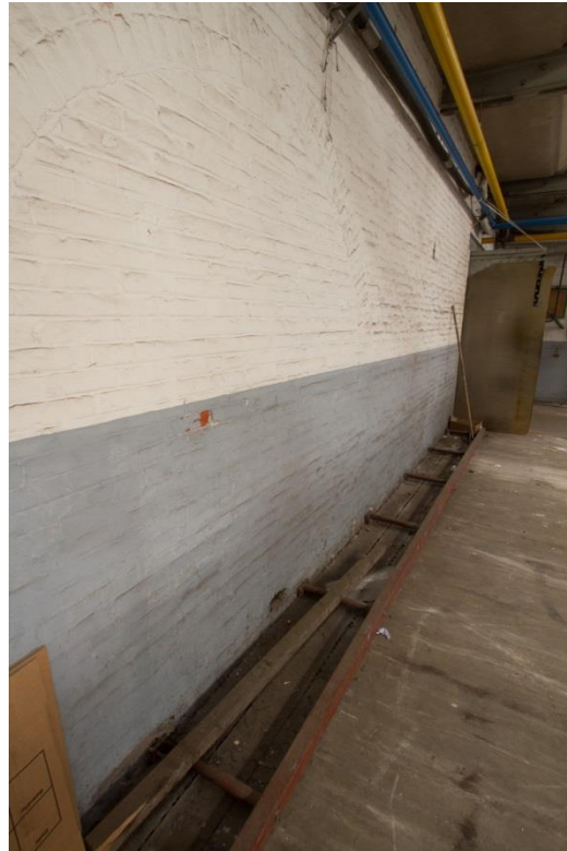
Afbeeldingen: Toepassing van een strijkspant maakt mede duidelijk dat de achtergevel reeds bestond ten tijde van de realisatie van gebouw XI. De gevel hoort oorspronkelijk een magazijn (gebouw X) toe. Rechts is te zien hoe een goot langs de voormalige gevel van de weverij (gebouw VI) inpandig raakte.
