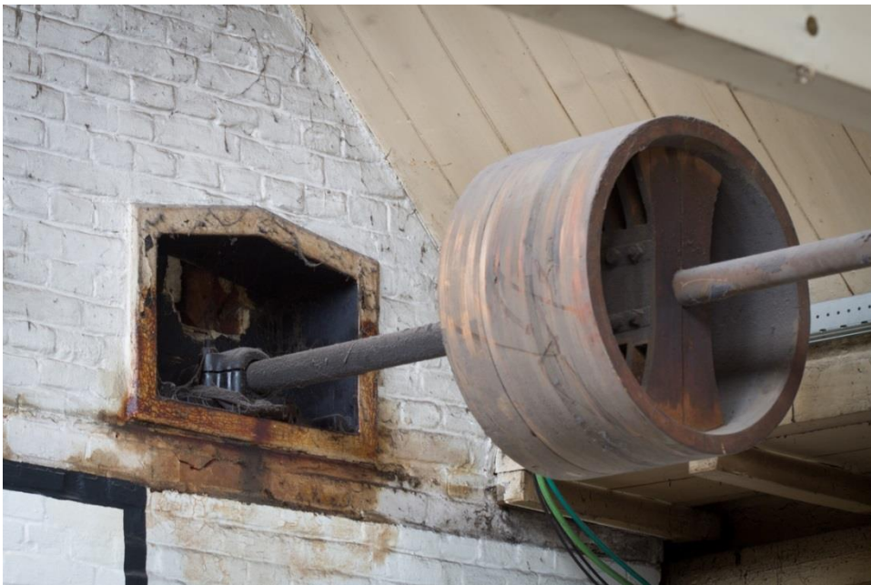
Afbeelding : In detail een oplegpunt ten behoeve van een as die over de balken van de spanten is aangebracht. Dit is één van de weinige plekken in het complex waar delen van de vroegere aandrijving nog aanwezig zijn.
