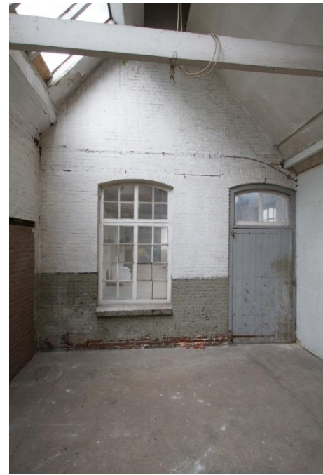
Afbeeldingen: Links een opname van de kapconstructie met rechts de goot óp de balken en een ventilatie- en lichtstraat die later, maar al wel vrij vroeg, zijn toegevoegd. Rechts de inpandig geraakte voorgevel, die oorspronkelijk niet geschilderd was. Deur en vensters zijn uit de bouwtijd.
