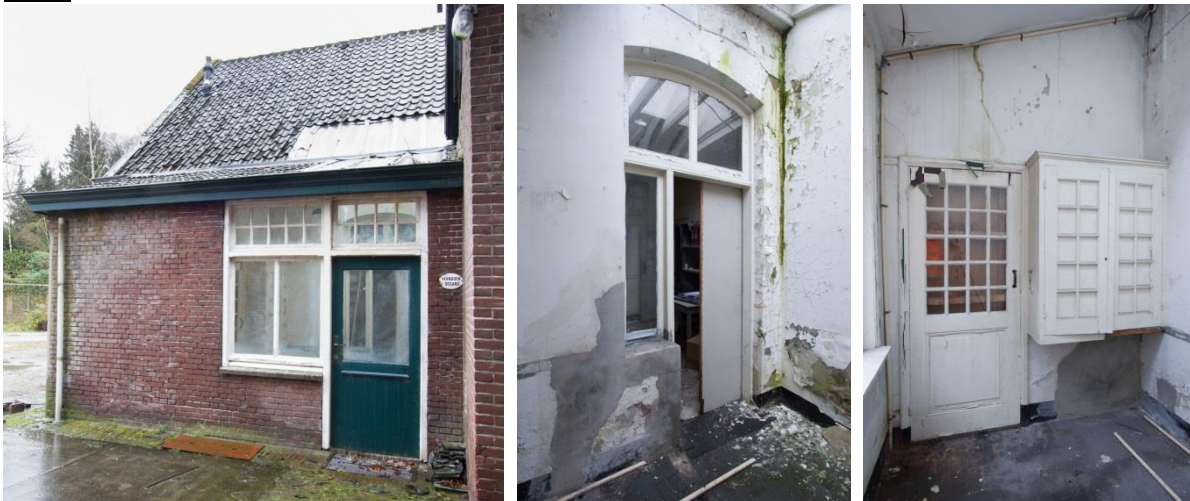
Afbeeldingen: Toegevoegde bouwmassa met entree (l). Voormalige gevelopening, inpandig geraakt door toegevoegde bouwmassa met entree (m). Paneel deur en kastje in de toegevoegde bouwmassa (r).
