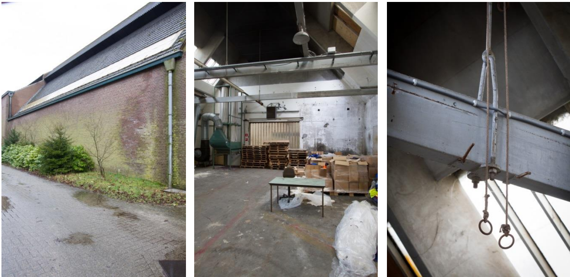
Afbeelding: Links één van de gesloten gevelvlakken. In het midden het interieur van de voormalige spoelerij. Rechts een detail van de wijze waarop de trekstangen van de spanten zijn bevestigd aan de balken. Daarbij koorden met ogen waarmee de luiken van de luchtkap in de nok van het gebouw kon worden bediend.
