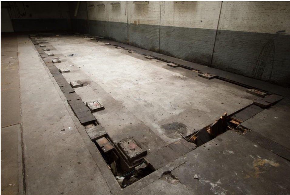
Afbeelding: Machinefundament in het bouwdeel uit 1907.
