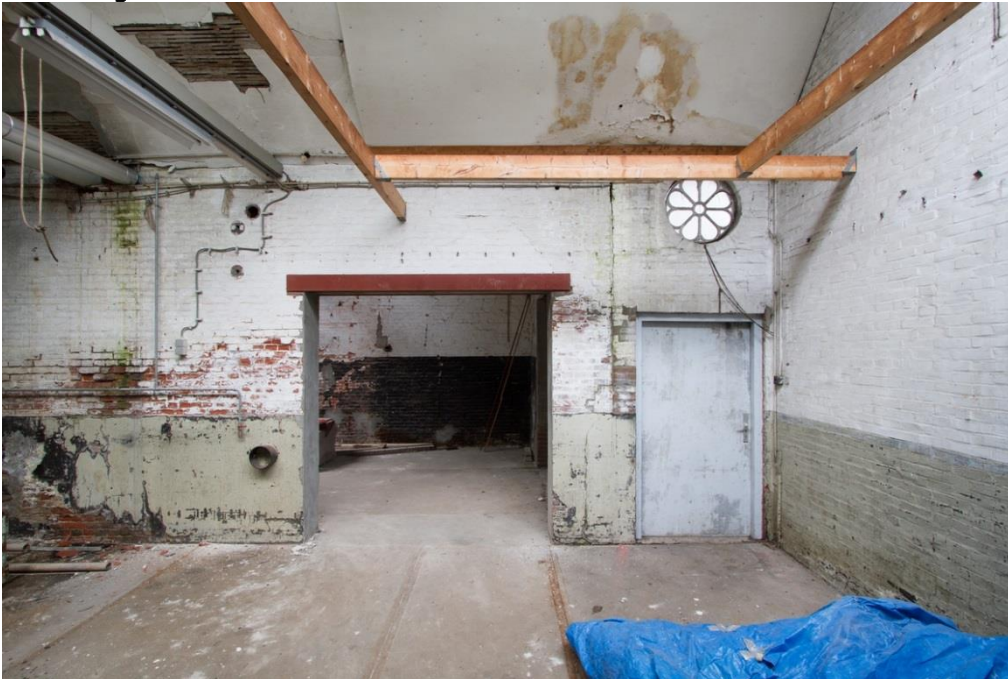
Afbeelding: Verticale bouwnaad waar het nieuwe muurwerk (rechts) aansluit op de oudere rechter zijgevel van gebouw VI, het voormalige ketelhuis. In die muur in een later stadium de huidige doorbraak gerealiseerd.
