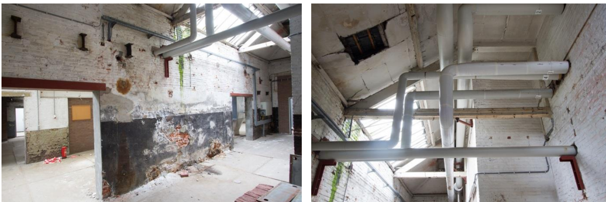
Afbeeldingen: Links de linker zijgevel van gebouw IV met daarin vrijwel louter later aangebrachte openingen. Uiterst rechts is mogelijk een oorspronkelijke gevelopening dichtgezet. De foto rechts toont een kapspant.
