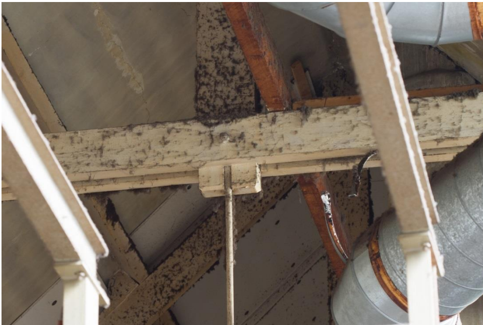
Afbeelding: Detail van de wijze waarop in 1907 de trekstang is bevestigd aan de nokstijl.
