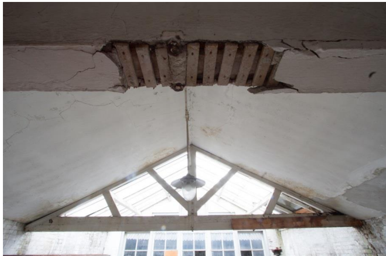
Afbeelding: Detail van de loopkraanconstructie en een opname van één van de spanten met op de voorgrond een beschadiging van de spantafwerking waaruit de opbouw blijkt. Hier is rachelwerk toegepast.
