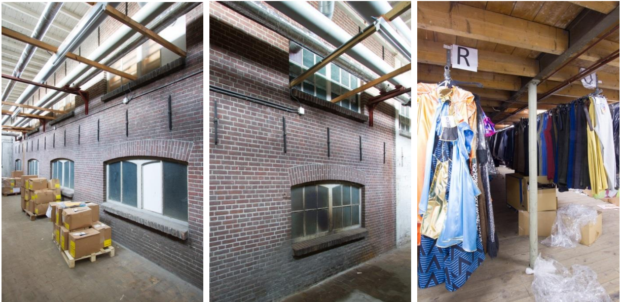
Afbeeldingen: Links een gevel met oorspronkelijke indeling en raamkozijnen (roeden verdwenen). Midden detail van de uitbreiding uit 1913 waar de ramen nog de oorspronkelijke zesruits indeling hebben. Rechts de draagconstructie van het oudste deel van het magazijn.
