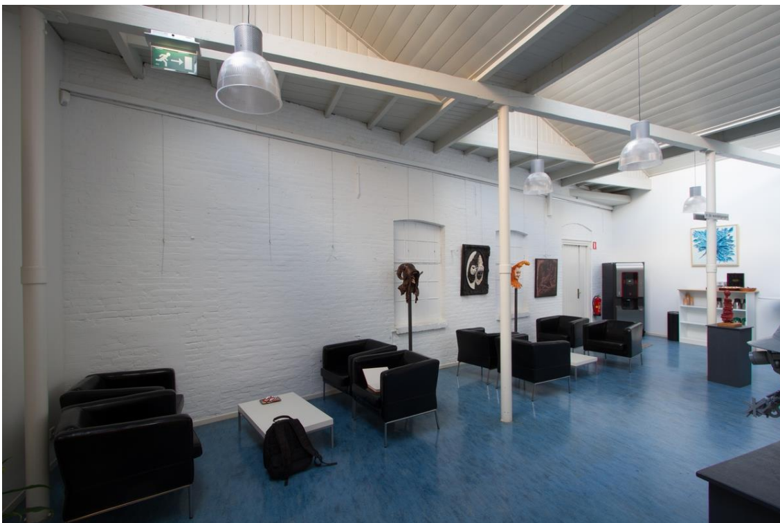
Afbeelding: Eenvoudige draagconstructie van gebouw XIV. Daarachter de voormalige gevel van gebouw VII die met de realisatie van gebouw XIV inpandig raakte.
