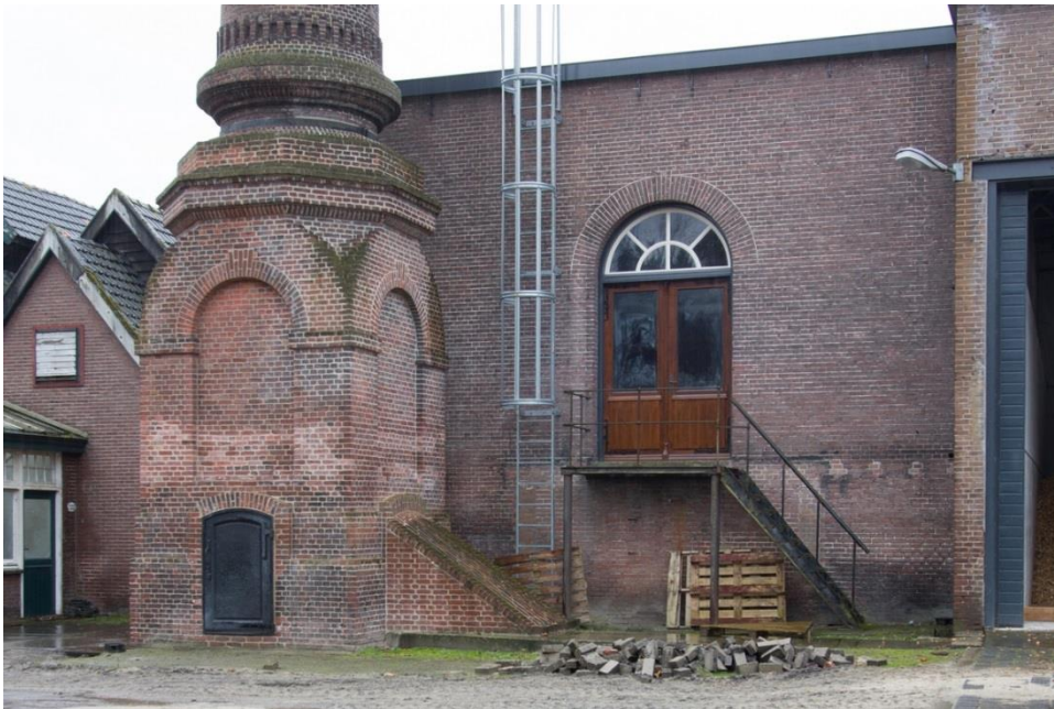
Afbeelding: De Machinekamer is in 1907 tot stand gebracht achter de schoorsteen uit 1892. De toegang tot de kamer is bereikbaar middels een ijzeren trap. Een deur in de linker zijgevel vormt de ontsluiting van de ruimte onder de machine.
