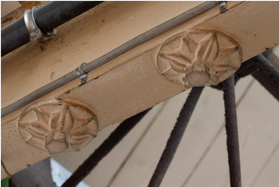
De lagers zijn door middel van bouten verbonden met de balken. De ringen zijn uitgevoerd met een floraal motief.
