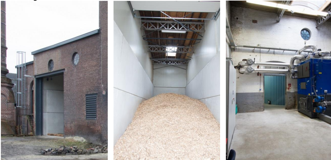
Afbeeldingen: Links de kopgevel van het gebouw met oorspronkelijke rondvensters en een toegevoegde deuropening ten behoeve van de houtsnipperbunker. In het midden een blik in de bunker met houtsnippers ten behoeve van de huidige verwarmingsketel. Rechts het inwendige van de ketelhuis met oorspronkelijke gevelinvullingen in rechts de huidige houtketel.
