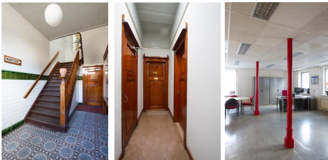
Afbeeldingen: De hal van het gebouw. Midden oorspronkelijke binnendeuren. Rechts één van ten minste drie gietijzeren kolommen op de begane grond.
