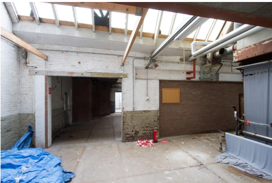
Afbeelding: De linker zijmuur van het gebouw is in oorsprong de rechter zijgevel van de ververij uit 1888 (gebouw I). Hierin later aangebrachte doorbraken. Boven de latei links is een oorspronkelijke segmentboog te onderscheiden.
