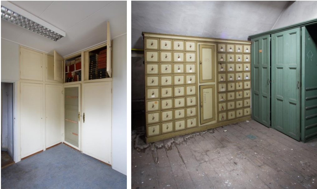
Afbeeldingen: Elementen in het interieur. Links oude inbouwkasten op de begane grond. Eén van de paneeldeuren is in het zicht gebracht door een plaat te verwijderen. Rechts oude kasten op de zolder van het gebouw.
