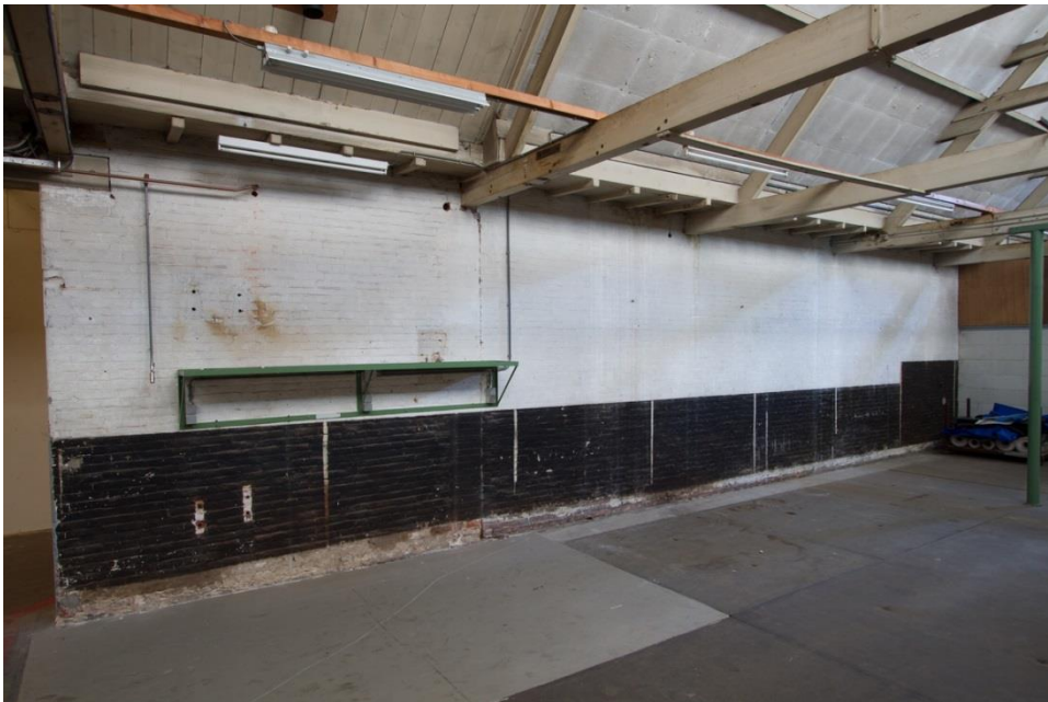
Afbeelding: Een verticale bouwnaad markeert de verlenging van het gebouw.
