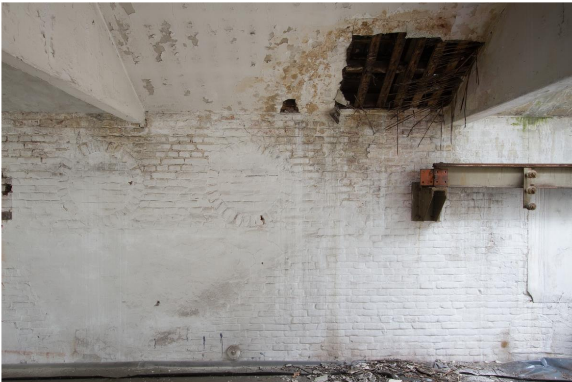
Afbeelding: Deel van de zijmuur boven de zoldervloer. Hierin zijn twee dichtgezette rondvensters te zien. Soortgelijke vensters zijn ook te vinden in het ketelhuis uit omstreeks 1914 (gebouw XX). Het is goed mogelijk dat in gebouw XIII ook ketels en wellicht nog een stoommachine zal hebben gestaan.
