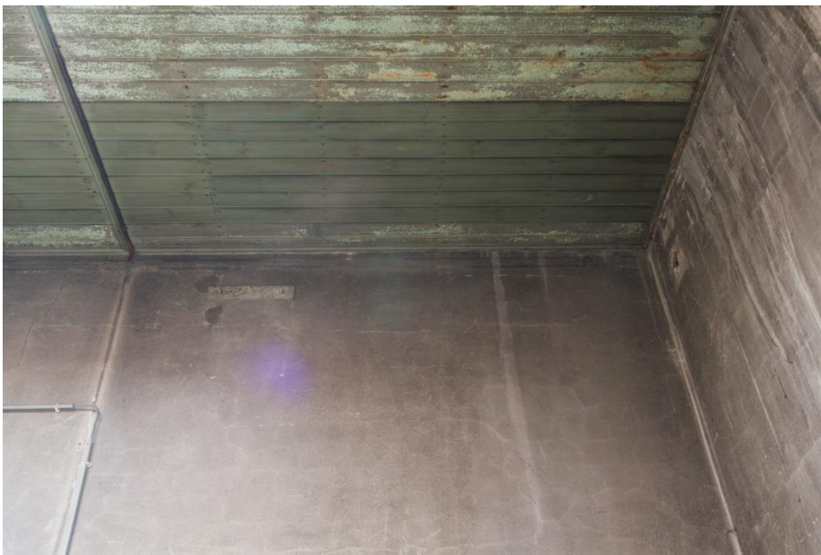
Afbeelding: Opname van muurafwerking en plafond in de machinekamer.
