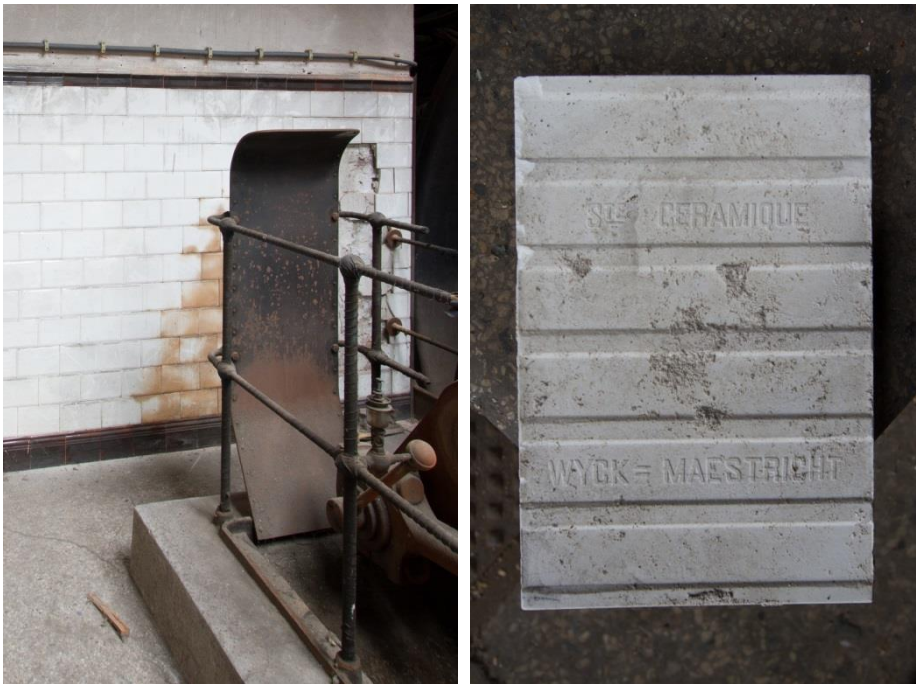
Afbeeldingen: De tegellambrisering in de machinekamer dateert uit de bouwtijd. Rechts de achterzijde van één van de losgelaten facettegels met daarop de naam van de fabriek Ste Ceramique.
