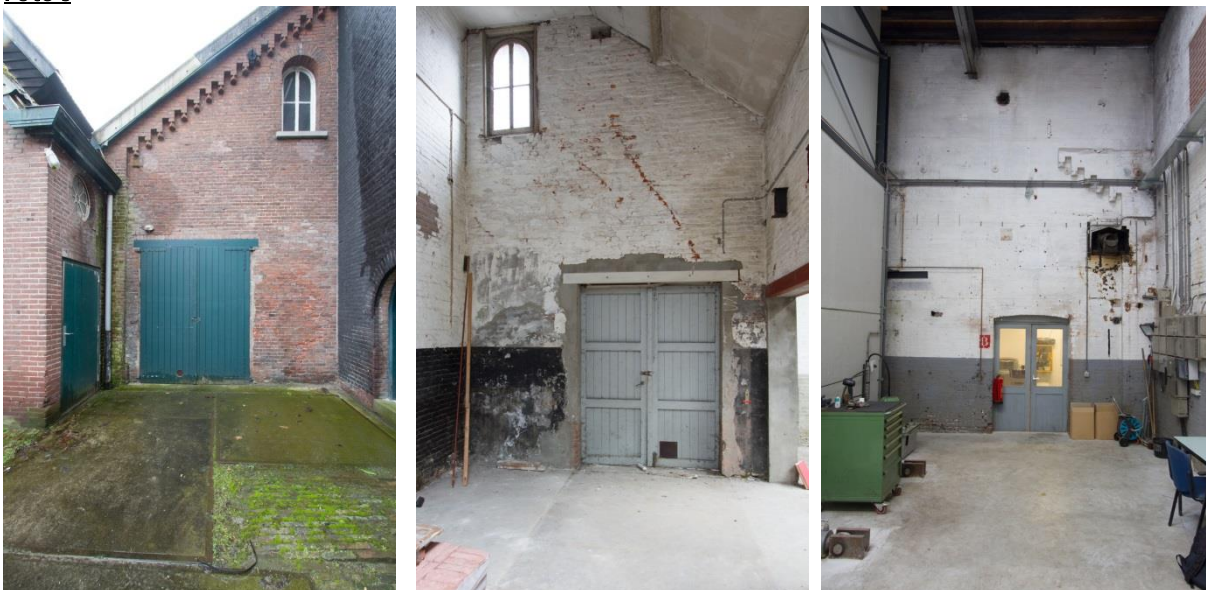
Afbeeldingen: Links de huidige voorgevel van gebouw IV is een restant van de in 1892 gebouwde voorgevel van het machine- en ketelhuis. In het midden dezelfde gevel van binnenuit gezien. De deur is duidelijk een toevoeging. Rechts een restant van de voormalige zijgevel van het machine- en ketelhuis, te zien vanuit het tegenwoordige ketelhuis. Eén en ander is af te leiden uit een hoekliseen en het restant van een blokfries.
