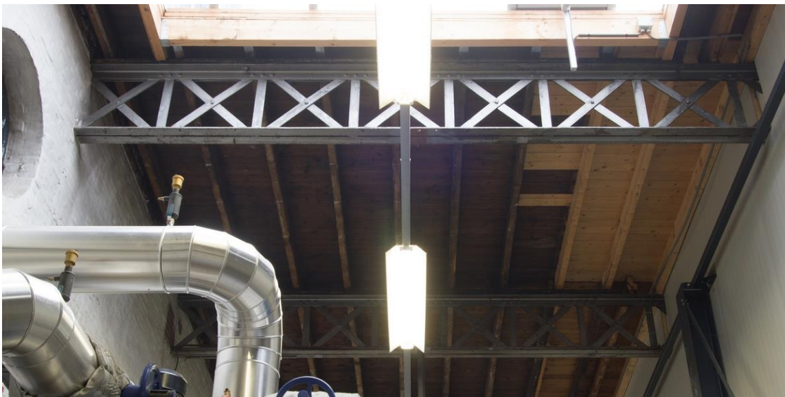
Afbeelding: De ijzeren liggers van het platte dak dateren uit de bouwtijd.
