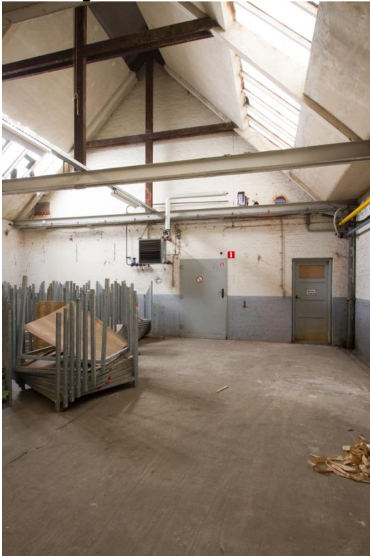
Afbeeldingen: Toepassing van een strijkspant maakt mede duidelijk dat de achtergevel reeds bestond ten tijde van de realisatie van gebouw XI. De gevel hoort oorspronkelijk een magazijn (gebouw X) toe. Rechts is te zien hoe een goot langs de voormalige gevel van de weverij (gebouw VI) inpandig raakte.
