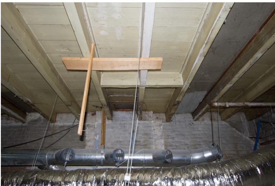
Afbeelding: Balklaag van de verdiepingsvloer.
