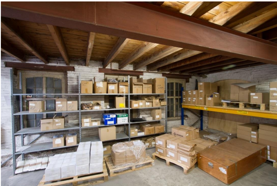
Afbeelding: Eenvoudige draagconstructie van de eerste verdiepingvloer. In de achtergrond oorspronkelijke vensters in de voormalige achtergevel van het gebouw.
