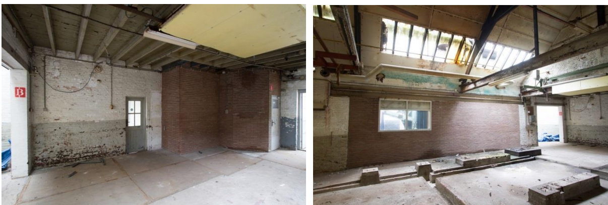
Afbeeldingen: Links, zicht op de muur tussen fabriek- en kantoorgedeelte. De enkelvoudige balklaag is vermoedelijk de oorspronkelijke. Rechts, vernieuwing van een del van de rechter zijgevel van het oudste deel van het gebouw.
