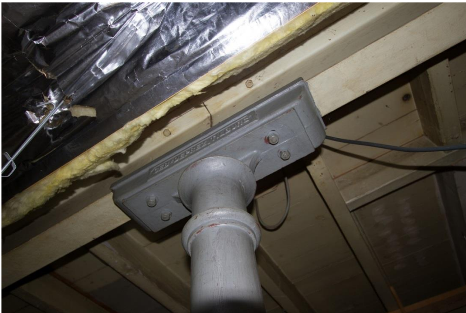
Afbeelding: De kop van één van de gietijzeren kolommen. Daarop het stempel van de firma Gebroeders Deprez uit Tilburg.
