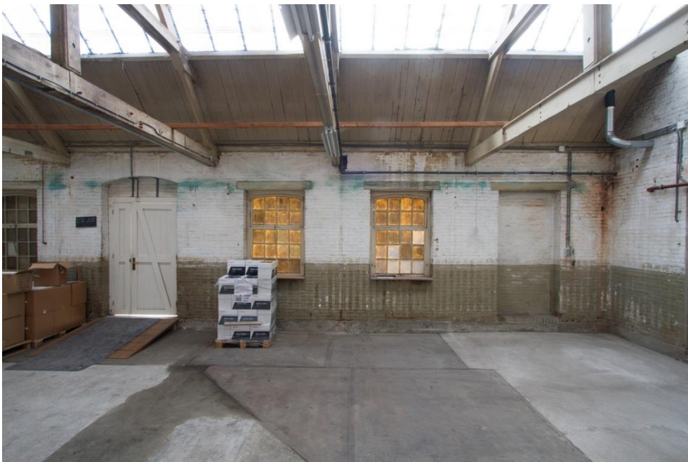
Afbeelding: Opname van binnen met zicht op de voormalige rechter zijgevel, door aanbouw inpandig geraakt. In de gevel zijn nog oorspronkelijke vensters en een oorspronkelijk deurkozijn aanwezig.
