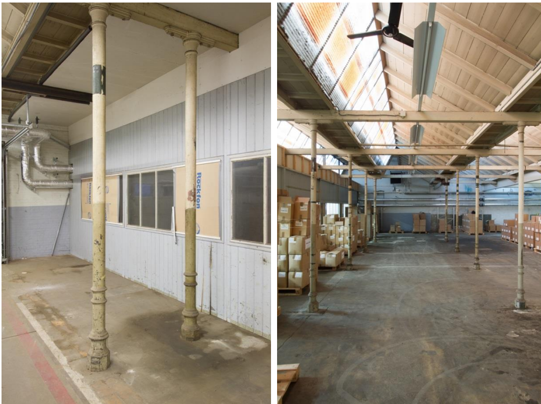
Afbeeldingen: Opname waarop de gietijzeren kolommen zijn weergegeven. Het lijkt er op dat vanaf 1888 en in de uitbreidingen tot omstreeks 1910 telkens identieke kolommen werden toegepast.
