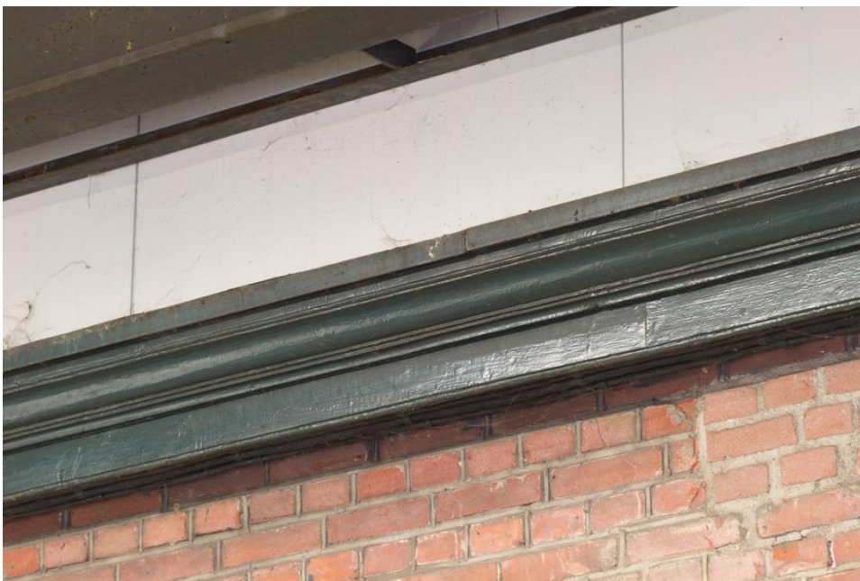
Afbeelding: Detail van de beëindiging van de oorspronkelijke voorgevel van het gebouw. Een opvallend rijk geprofileerde goot, vermoedelijk een product van gietijzer. Thans inpandig.
