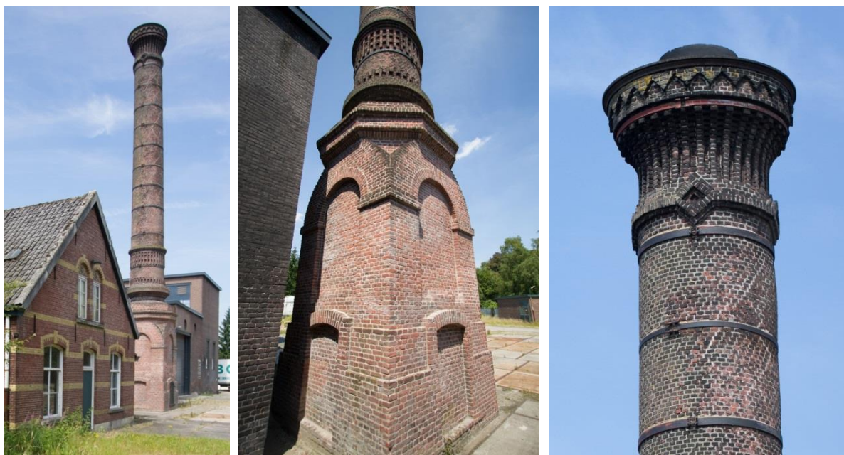
Afbeeldingen: De schoorsteen en details van de schoorsteen. Links met op de voorgrond de voorgevel van gebouw I. In het midden is direct naast de schoorsteen muurwerk te zien van de machinekamer die in 1907 werd gebouwd.
