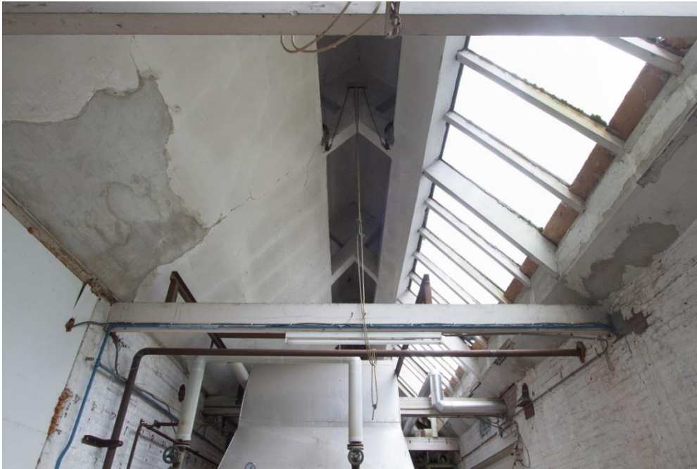
Afbeelding: De kapconstructie van het gebouw met oorspronkelijke spanten en afwerkingen.
