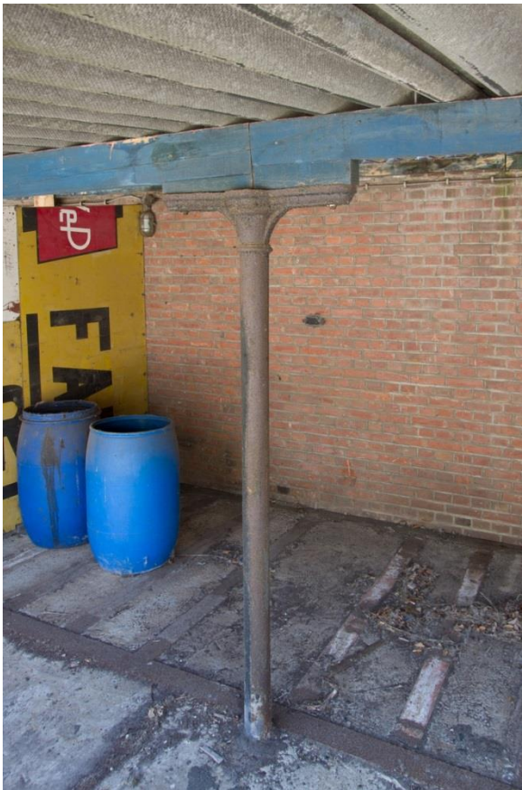
Afbeeldingen: De kolommen zijn van gietijzer, uit omstreeks 1900 en vrijwel zonder twijfel afkomstig van de weverij (gebouw VI). De detaillering is vrijwel identiek, niet exact gelijk. Rechts een opname van kolommen zoals thans nog aanwezig in de weverij.
