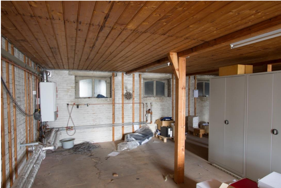
Afbeelding: Opname op de eerste verdieping met zicht op een houten kolom men vensters in de oorspronkelijke achtergevel.
