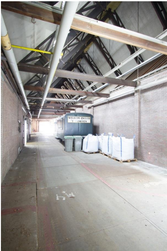
Afbeeldingen: Inwendige van het voormalige magazijn. De muur rechts is secundair, vermoedelijk een uitbreiding van de ververij. Rechts een blik in deze vermoedelijke uitbreiding die in pandig tot stand is gebracht.
