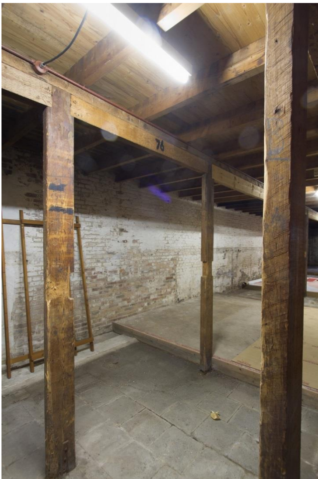
Afbeelding: De draagconstructie in de magazijnen is eenvoudig te noemen, passend bij de functie.
