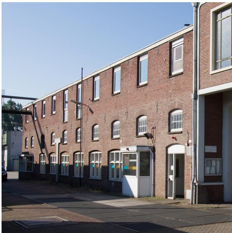
Afbeelding: De lange gevel van gebouw VIII. De eerste ophoging is nauwelijks waarneembaar in het metselwerk, temeer omdat gevelopeningen op eenzelfde wijze zijn gedetailleerd. De meest recente ophoging is vrij makkelijk waar te nemen.
