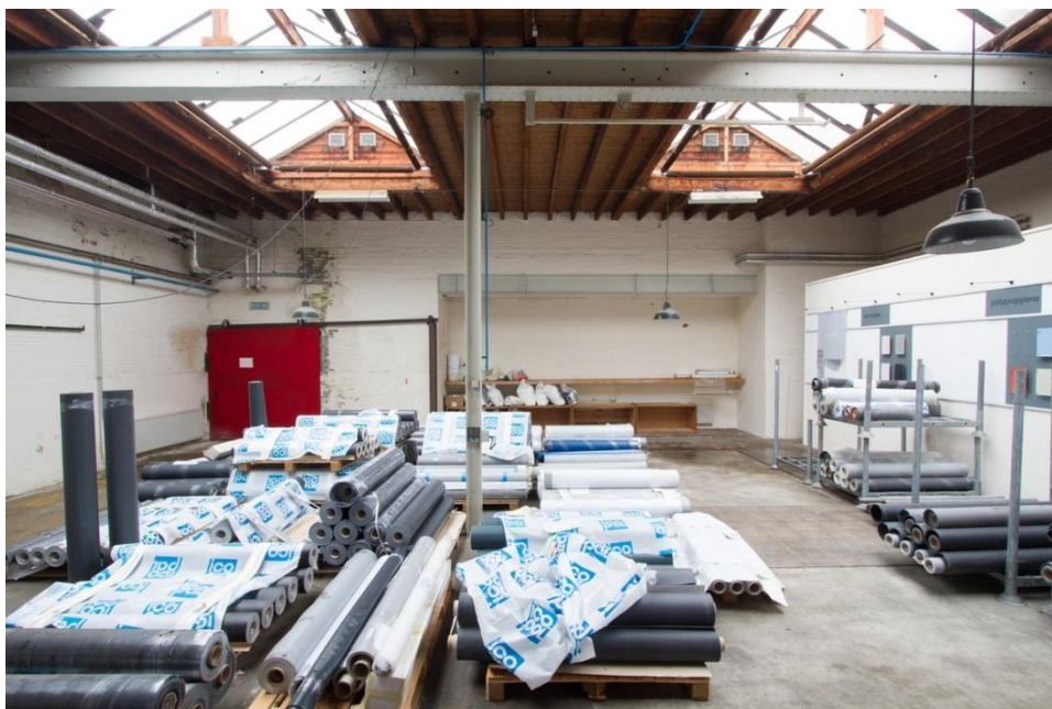
Afbeelding: Overzicht van gebouw V. De draagconstructie is volledig uit de jaren vijftig. De muur links gaat vermoedelijk nog terug tot de late negentiende eeuw.
