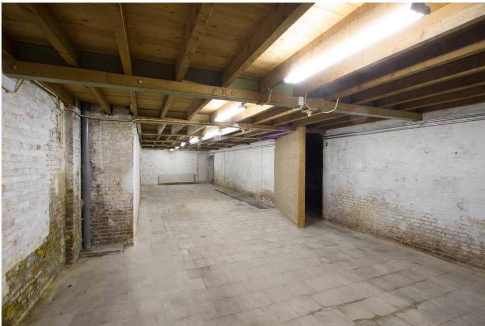
Afbeelding: Voormalig magazijn met metselwerk dat van vóór 1953 dateert. De balklagen zijn uit de jaren vijftig. Op enkele plekken is daarbij (her)gebruik gemaakt van ouder hout.
