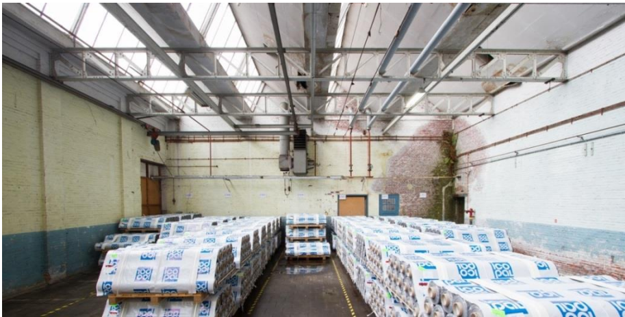
Afbeelding: De uitbreiding van de weverij, gebouwd in 1909 tegen de achtergevel van de weverij uit 1905. Die gevel is links op de foto te zien. De opname toont ook de ijzeren N-liggers.
