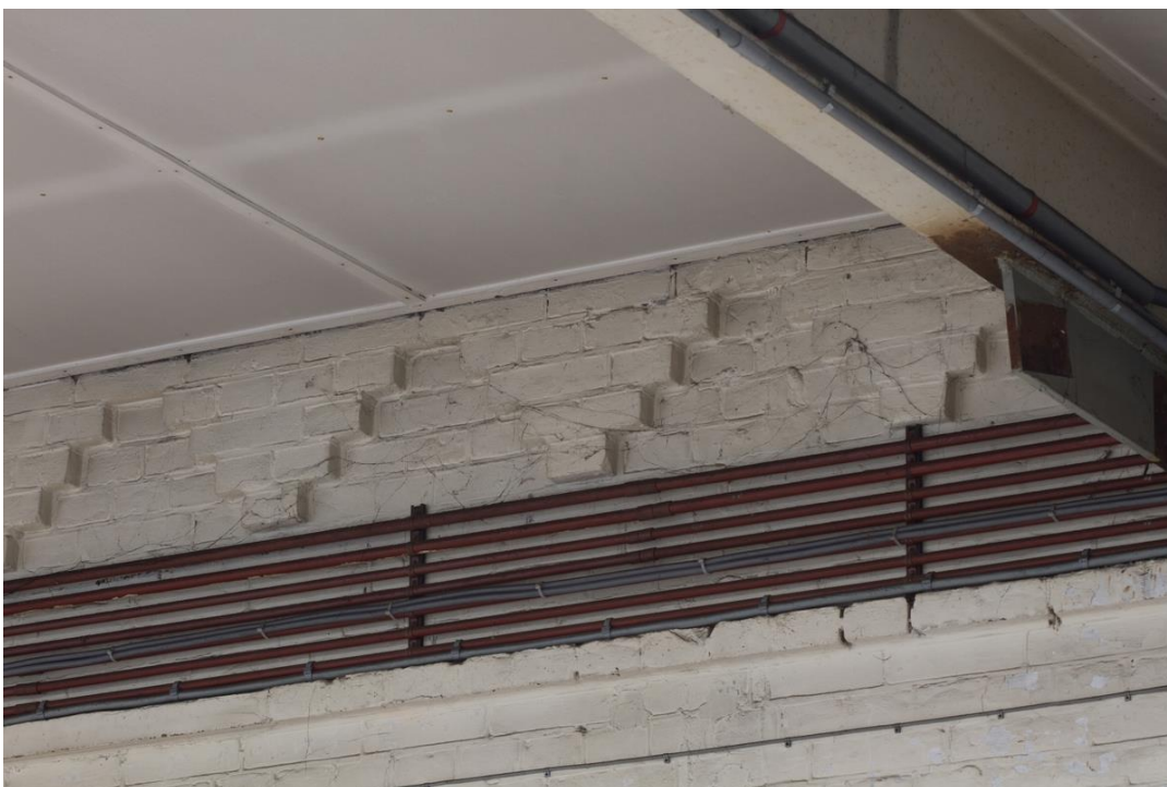
Afbeelding: Een detail van het gemetselde fries waarmee het gebouw in 1905 werd uitgevoerd.
