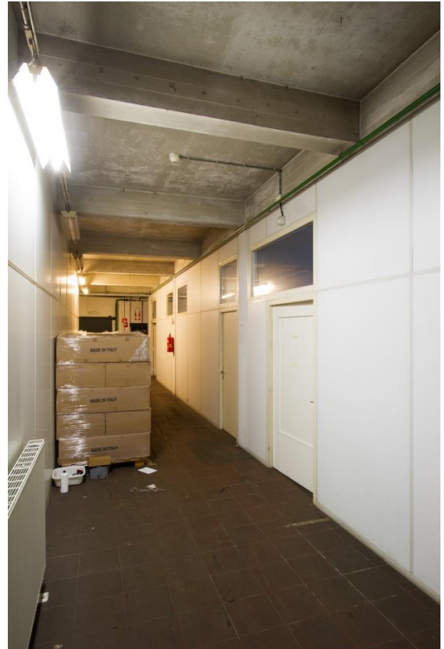
Afbeelding: Voormalige inpakruimte met betonconstructie en later toegevoegde wanden.
