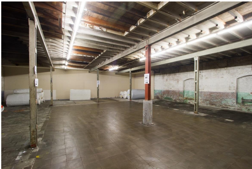
Afbeelding: Interieur van het magazijn. Dichtgezette gevelopeningen rechts maken deel uit van een ouder (thans gesloopt) gebouw, waartegen het magazijn werd opgericht. Daglicht kwam oorspronkelijk binnen via lichtkoven in het dak.
