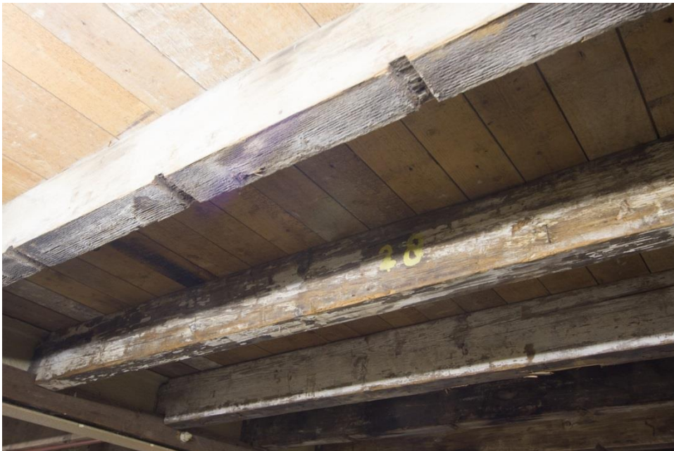
Afbeelding: Balken zijn hier hergebruikt om in de vloer uit de jaren vijftig te dragen.
