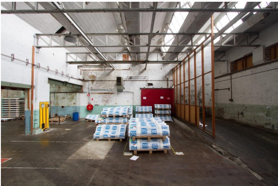
Afbeelding: Het oudste deel van de weverij, gezien in de richting van gebouw IX dat hier nog laat negentiende-eeuws metselwerk heeft. Dat metselwerk is opgehoogd om het dak van de weverij uit 1905 mogelijk te maken.
