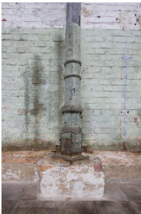
Afbeelding: Detail van één van de gietijzeren kolommen. Op basis van de detaillering is een datering van de kolommen omstreeks 1900 aannemelijk. Dit is passend voor de bouwtijd van de weverij, 1905.
