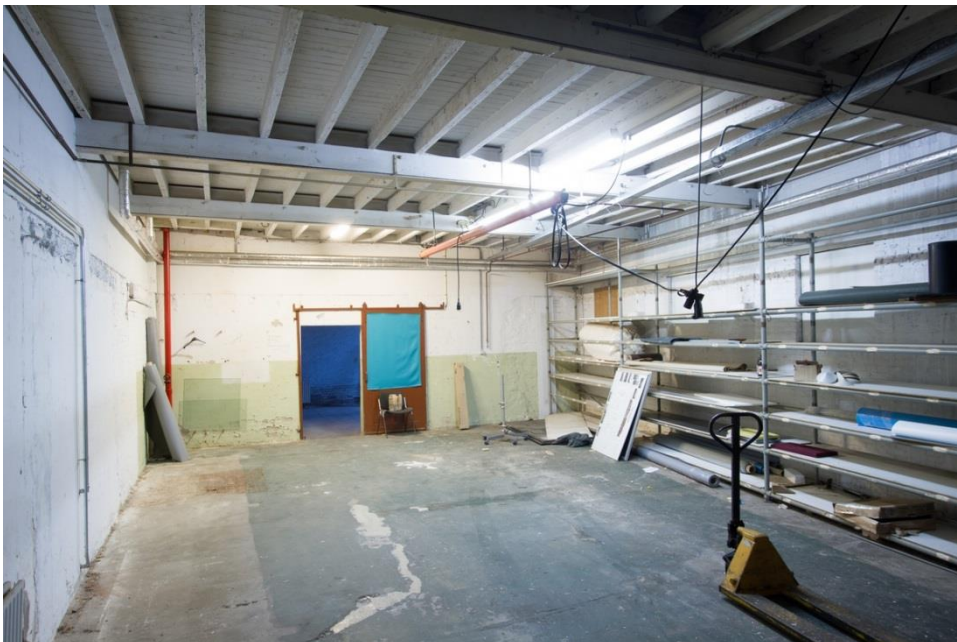
Afbeelding: Eenvoudige balklagen en samengesteld uit staal en hout. Rechts de voorgevel van het gebouw. Hier stond oorspronkelijk de schoorsteen van de fabriek. De muur links is vermoedelijk nog een negentiende-eeuws restant.
