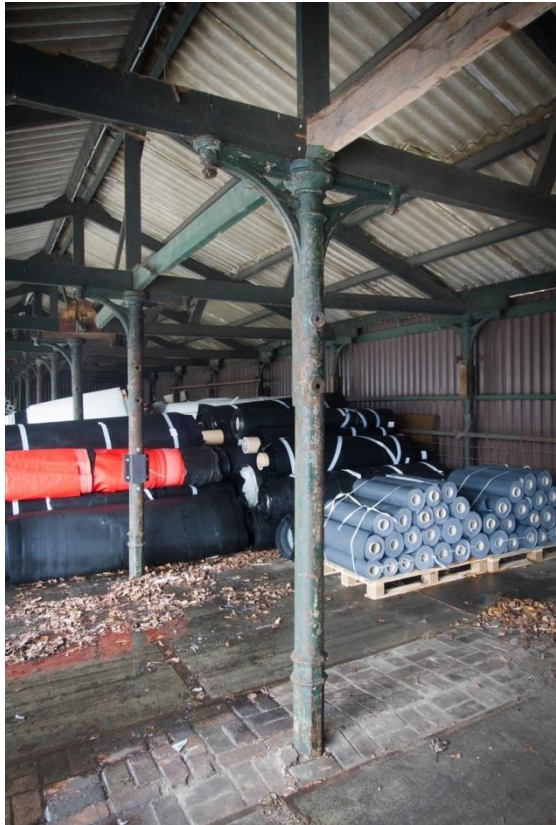
Afbeelding: Eén van de kolommen van de loods. Rechts in het gebouw, waar de eenvoudige dakconstructie uit de jaren vijftig van de vorige eeuw zichtbaar is.
