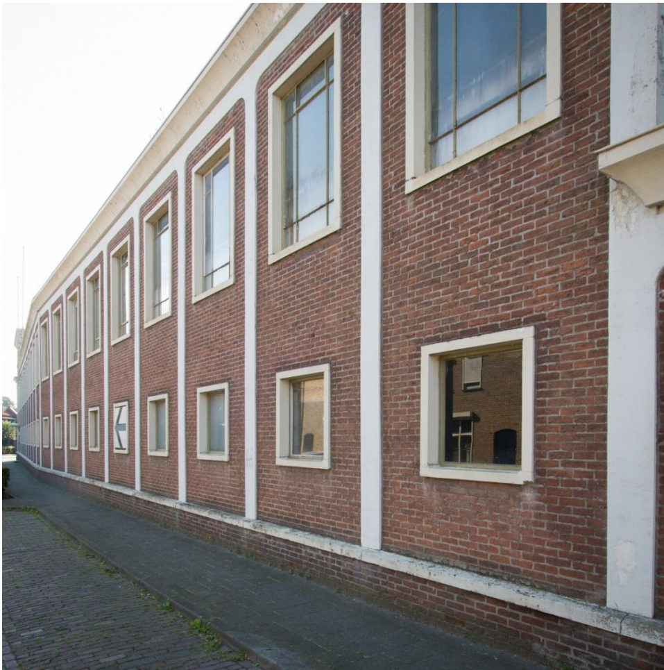
Afbeelding: De voorgevel van gebouw III. De knik in de rooilijn markeert de overgang van gebouw III op het iets oudere gebouw II.
