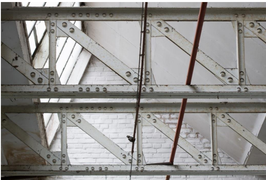
Afbeelding: Detail van de vroeg twintigste-eeuwse N-liggers in de uitbreiding van de weverij.
