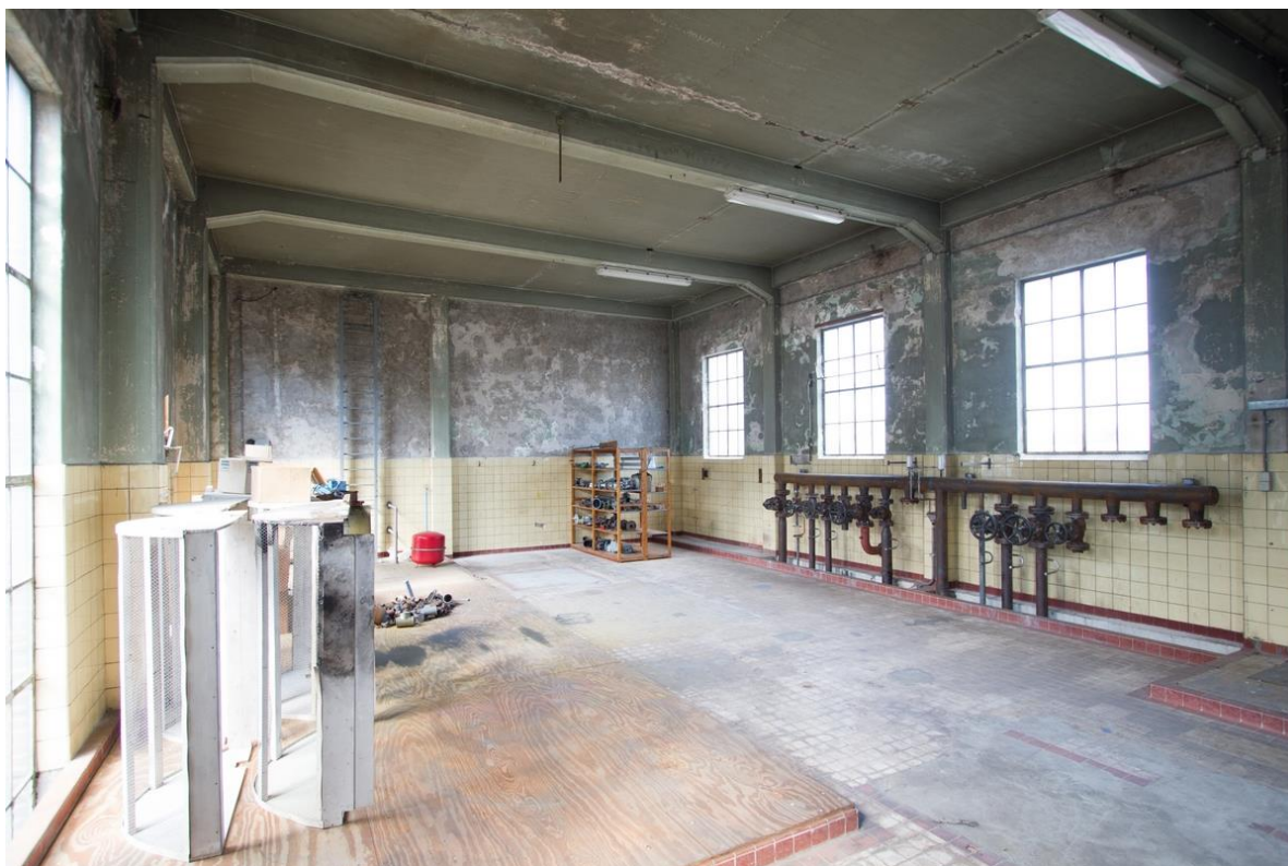
Afbeelding: Interieur van het gebouw op de verdieping. Draagconstructie van gewapend beton en vermoedelijk de oorspronkelijk wand- en vloerbetegeling.
