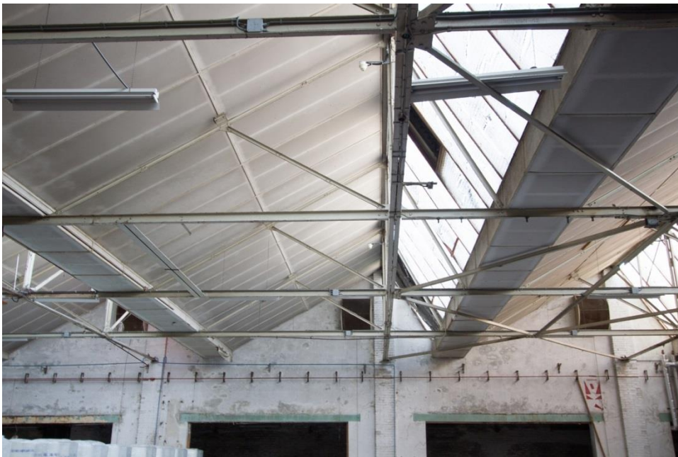
Afbeelding: Opname waaruit de ijzeren dakconstructie inzichtelijk wordt.
