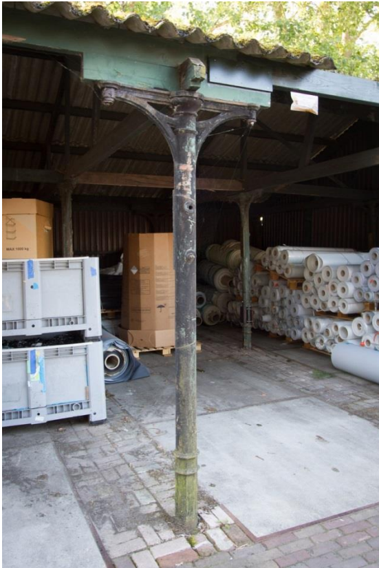
Afbeelding: Eén van de kolommen van de loods. Rechts in het gebouw, waar de eenvoudige dakconstructie uit de jaren vijftig van de vorige eeuw zichtbaar is.
