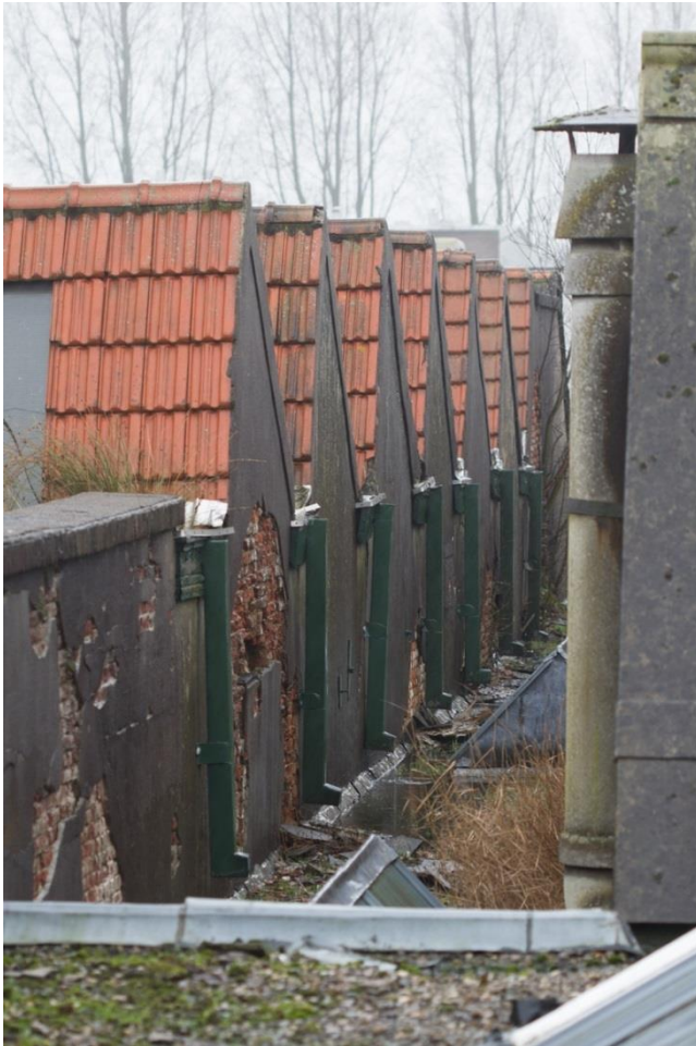
Afbeelding: Mogelijk een negentiende-eeuws restant muurwerk (de toppen zijn deels uit de tijd van de bouw van gebouw VII). Oorspronkelijk sloot de kapconstructie van gebouw IX lager op deze muur aan. Bij de verbouwing in 1950 kreeg de gang een plat dak en werd de gangmuur (rechts op de foto) hoger opgetrokken ten behoeve van de huidige kapconstructie.
