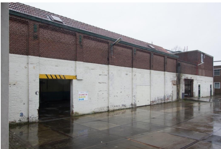
Afbeelding: Achtergevel van de uitbreiding van de weverij met lisenen en een fries met bloktand.
