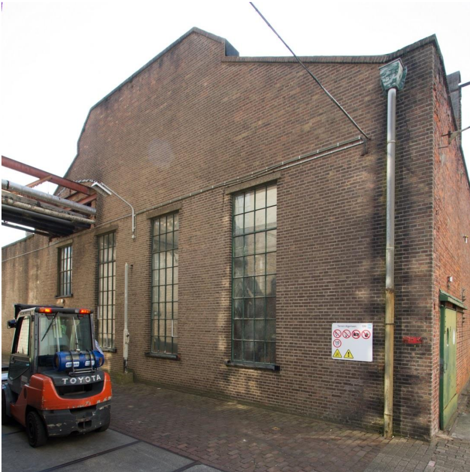
Afbeelding: De vernieuwde gevel van het ketelhuis. Vernieuwing van de gevel moet vermoedelijk worden gezien in het licht van het vervangen of bijplaatsen van ketels.
