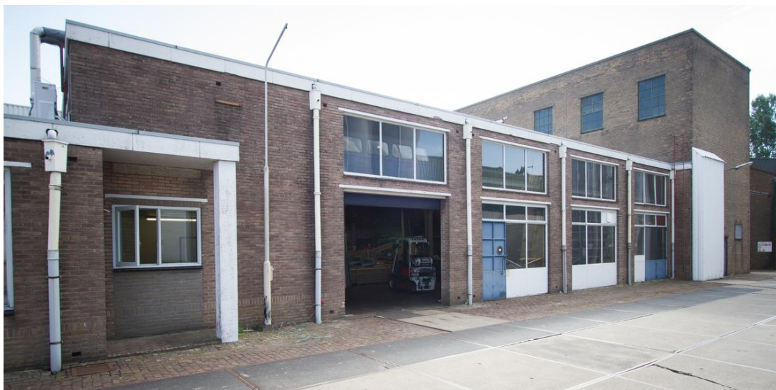
Afbeelding: Deel van de voorgevel van het gebouw met rechts het voormalige accu- en pompgebouw (XVI).
