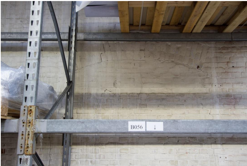
Afbeelding: In oorsprong reeds een inpandige gevel. Hierin zijn enkele dichtgezette deuropeningen onder segmentboog weergegeven. De openingen zijn ook te zien op de bouwtekening uit 1907. Opname vanuit de voormalige spoelerij.
