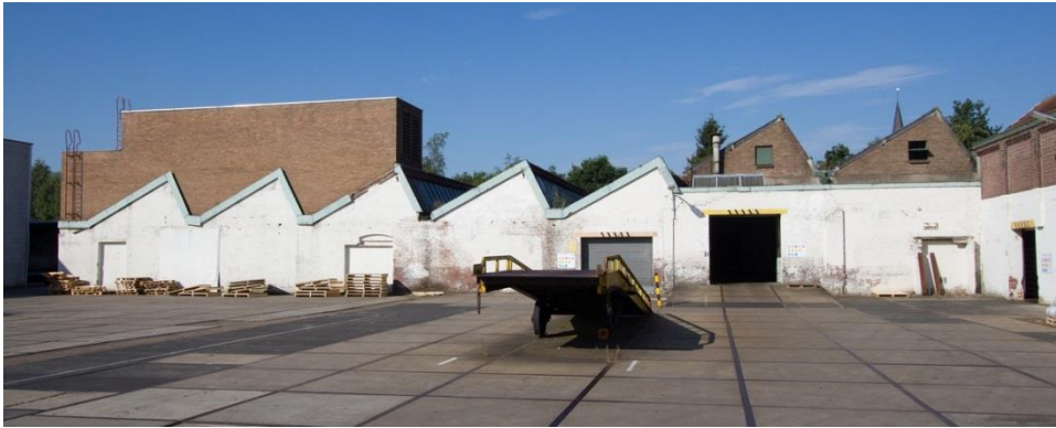
Afbeelding: Door gedeeltelijke sloop is een voormalige binnenmuur verworden tot gevel. Doorgangen daarin zijn alle vermaakt of dichtgezet.
