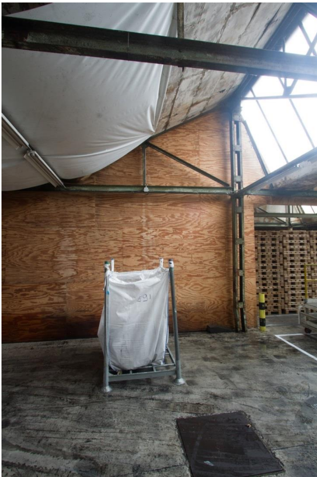
Afbeelding: Deel van de draagconstructie uit 1915 die nog aanwezig is.
