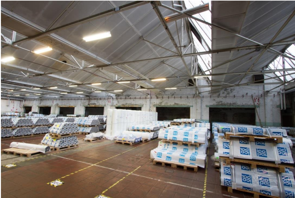
Afbeelding: Gebouw IX met zicht op de draagconstructie uit de jaren vijftig en de ingrijpend gewijzigde, laat negentiende-eeuwse gevel waarin doorbraken zijn gemaakt en waarop nieuwe toppen zijn gemetseld.
