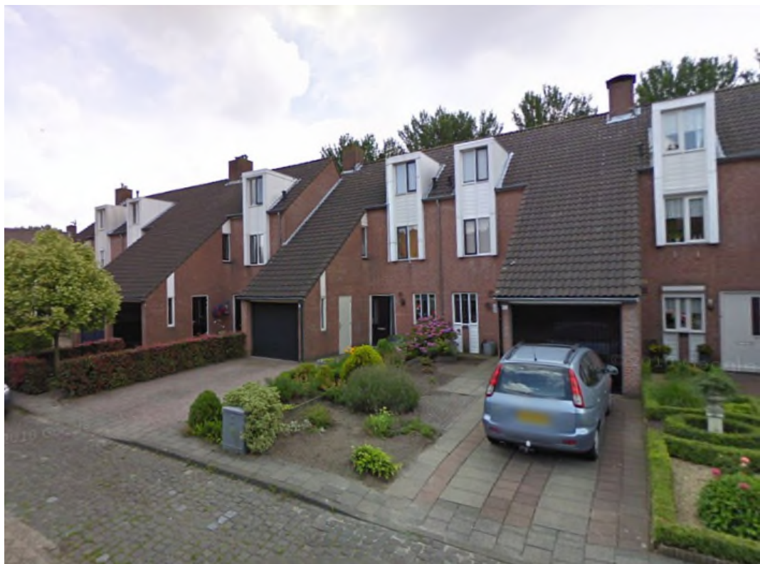
Woningen aan de Vonderstraat (bron: maps.google.nl)
