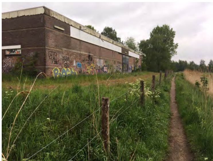
Figuur 3. Bestaande bebouwing
