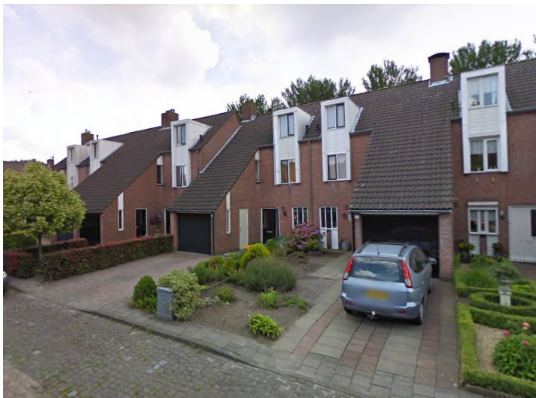
Woningen aan de Vonderstraat (bron: maps.google.nl)
