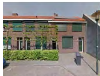
Bestaande situatie Kerkstraat v
