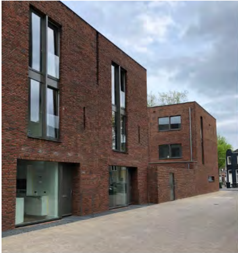
^ Grote gevelopeningen tot aan de grond en diep terugliggende entrees aan fabrieksstraat
