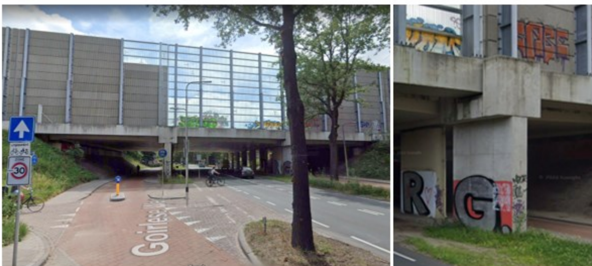
Figuur 3 Aparte draagconstructie geluidsscherm Tilburg
