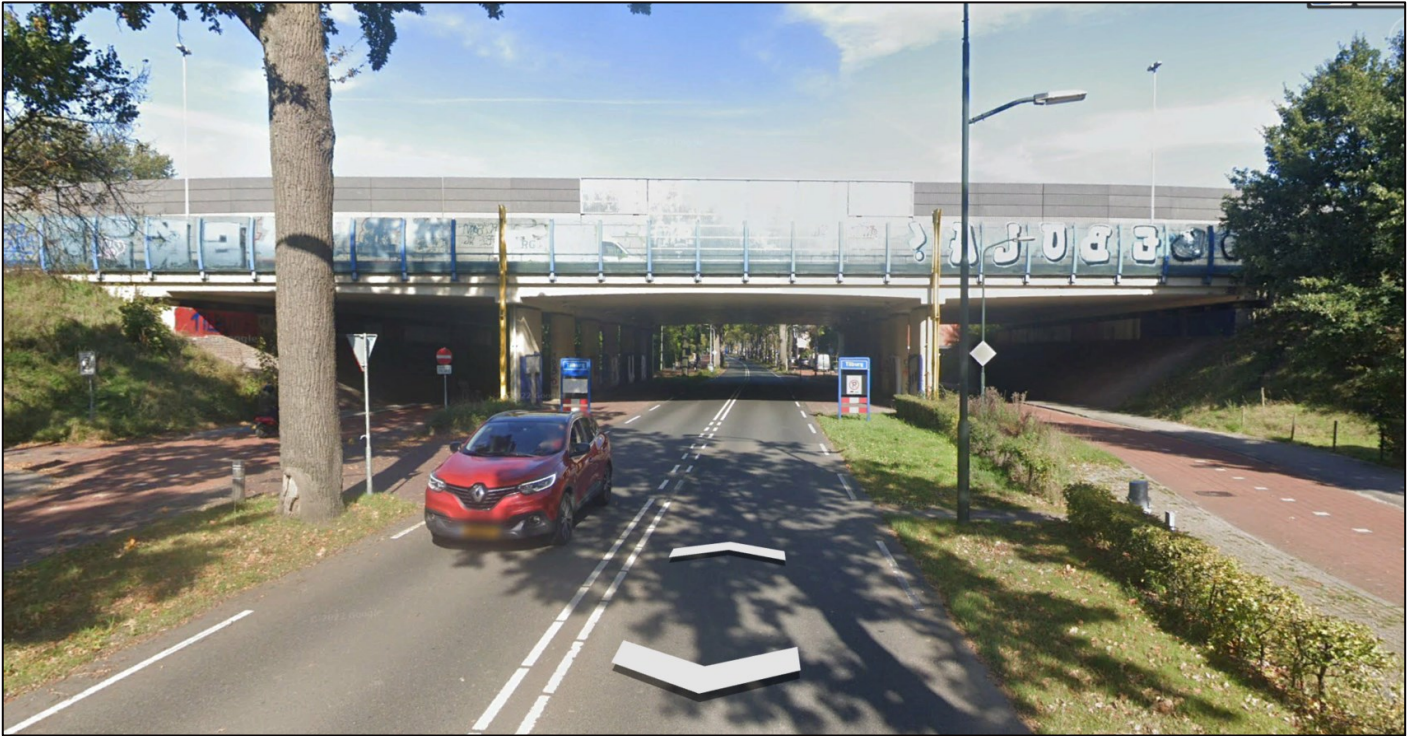
Figuur 11 Aanzicht bestaand viaduct (bron Google)
