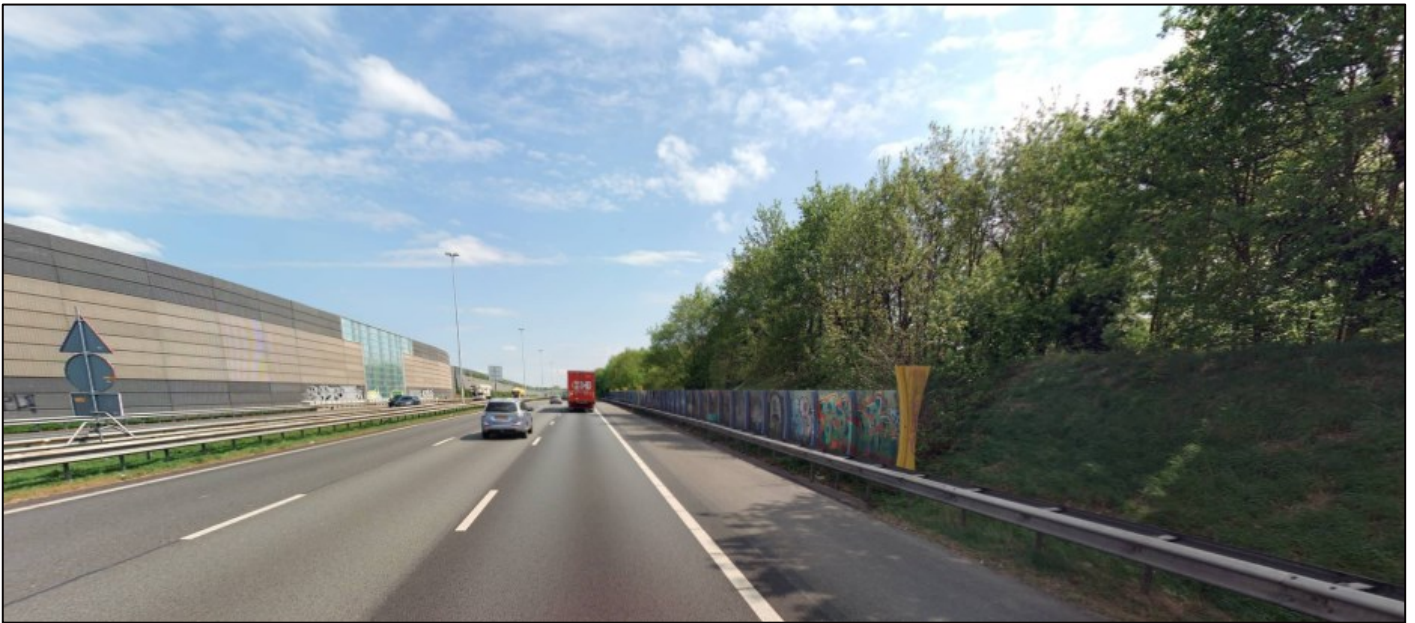
Figuur 10 Huidige situatie grondwal en geluidsscherm (Bron: Cyclomedia Streetsmart)
