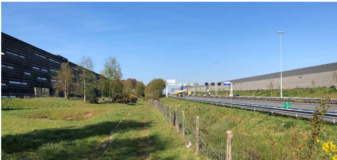
Afbeelding 1. Geluidscherm A58 (zijde Tilburg) en appartementen-complex (zijde Goirle)
