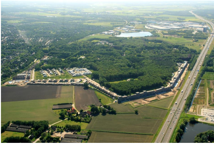
BOSCHKENS – bestaande geluidsmuur langs A58 met woningen
