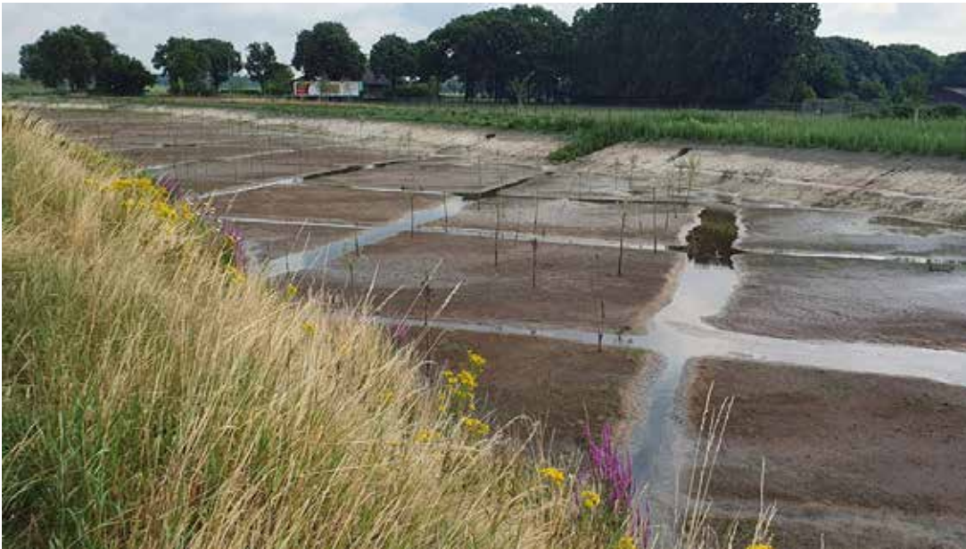
Afbeelding 4.1: Net aangelegd doorstroommoeras in EVZ De Grootte Leij
