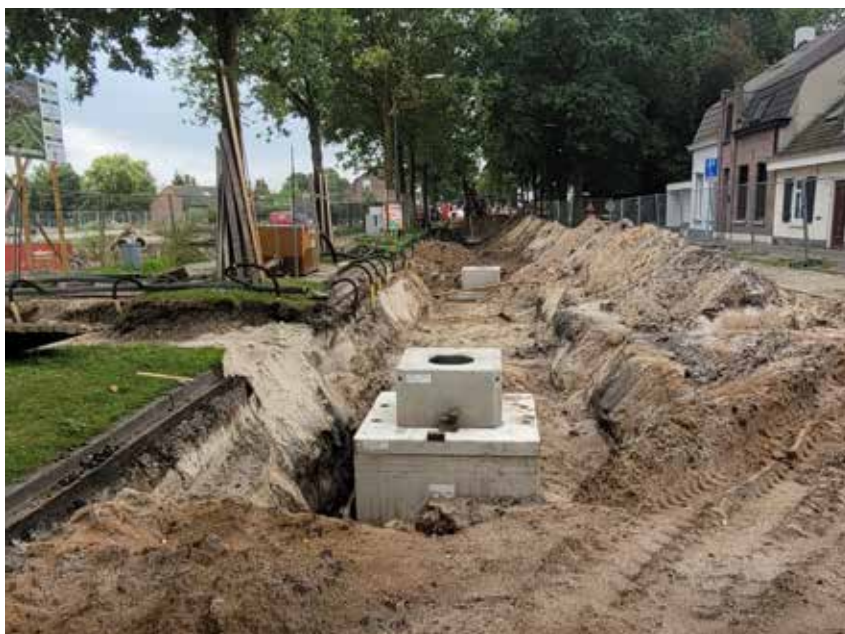
Afbeelding 4.2: Aanleg gescheiden regenwaterriool in de Bergstraat
