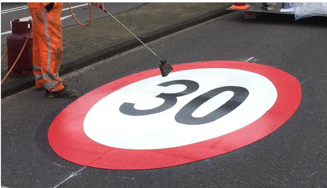
Foto ter illustratie, wegmarkering maximale snelheid 30 km/u in thermoplast
