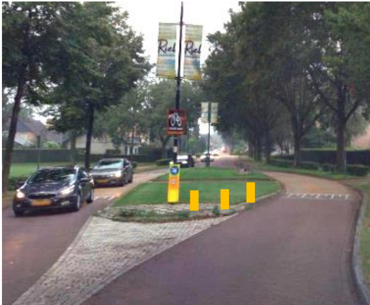
Locatie van de extra rijbaangeleiders, foto ter illustratie van een rijbaangeleider
