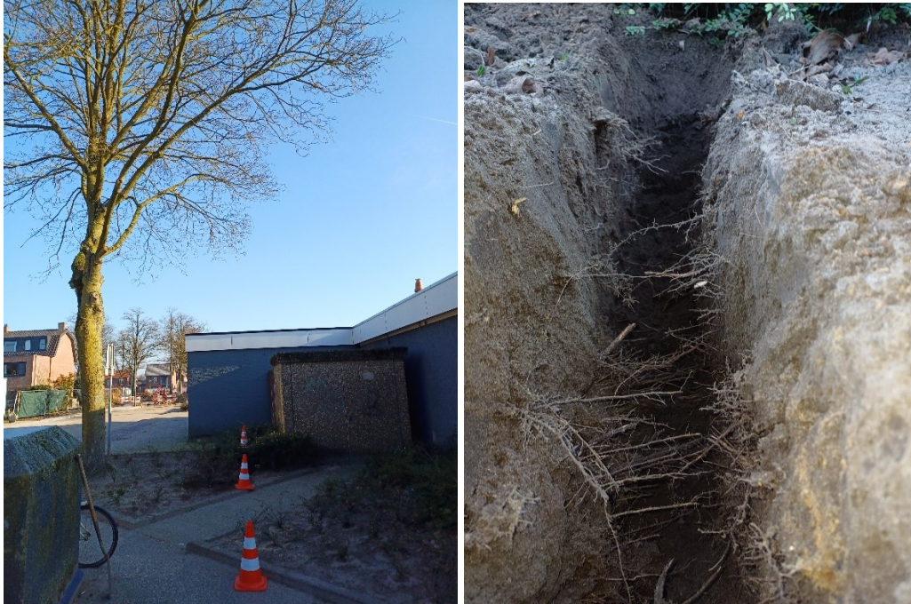
Foto 4 links: Voorbeeldweergave van ontgravingslocatie naast boom 5. De pionnenrij geeft de voorgenomen gevel van de nieuwbouw weer. De proefsleuf is gegraven bij de middelste pion.
