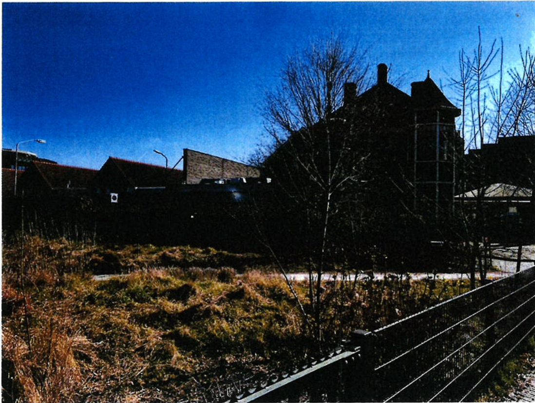
Figuur 4: Zicht over het plangebied met restaurant Flanders en de achterzijde van de Hovel. Allemaal lage bebouwing.
