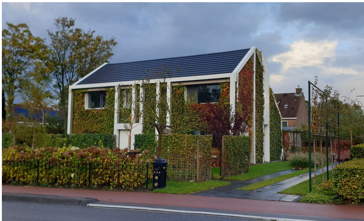
Groene gevel met grondgebonden beplanting,, Nootdorp, foto Nanda Sluijsmans
