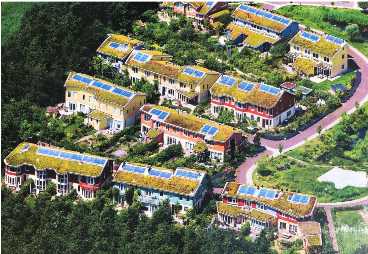
Groene daken met zonnepanelen, woonwijk de Buitenkans, Almere
