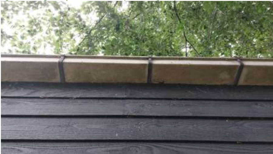
Figuur 4.4.2. Tussen het hout en de goot is geen ruimte aanwezig die toegang verleent aan vleermuizen.
